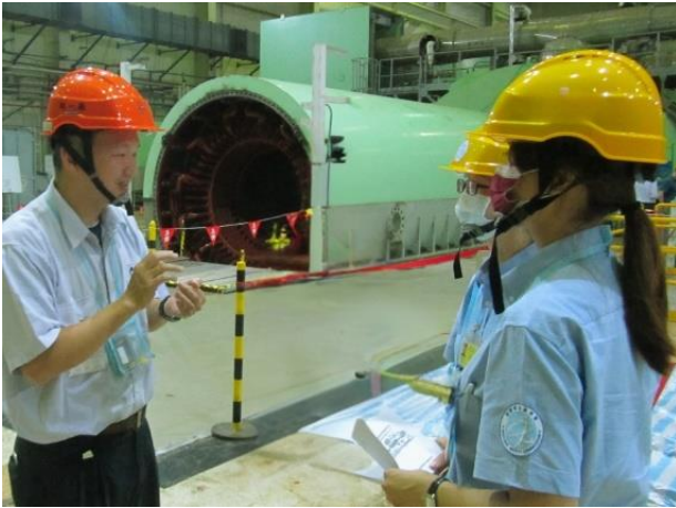
圖3、查證核一廠2號機汽機廠房主發電機設備拆除區域現況
