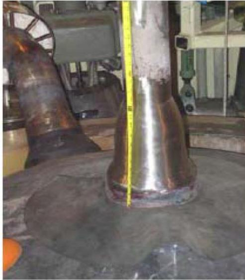
圖 1.6 Millstone 3 之 Spray 管嘴與覆鍍示意圖與成品外觀照 [29]。
