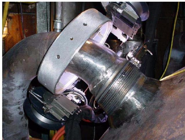
圖 1.5 D.C. Cook Unit 1 之安全端與飼水管嘴覆銲示意圖與施作外觀照 [29]。
