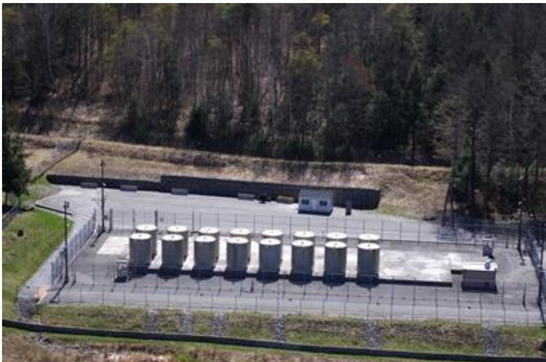
圖 4-3、Yankee Rowe 核能電廠的 ISFSI
