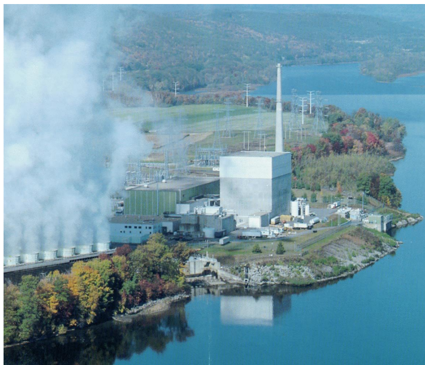
圖 3.3 除役前 Vermont Yankee 核電廠的外觀鳥瞰照片
