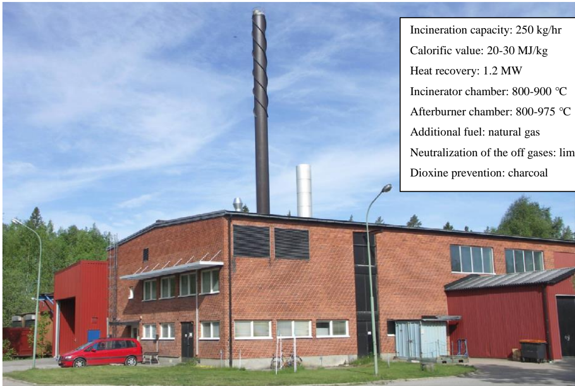
圖 3-3 瑞典 Studsvik 公司放射性廢棄物焚化爐照片和相關參數
