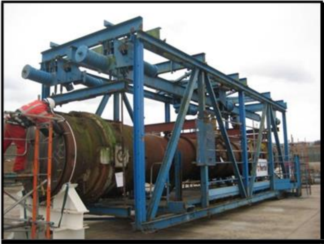
圖 5.6 頂蓋橋從熱交換器上移除用來取樣以調查活度濃度
