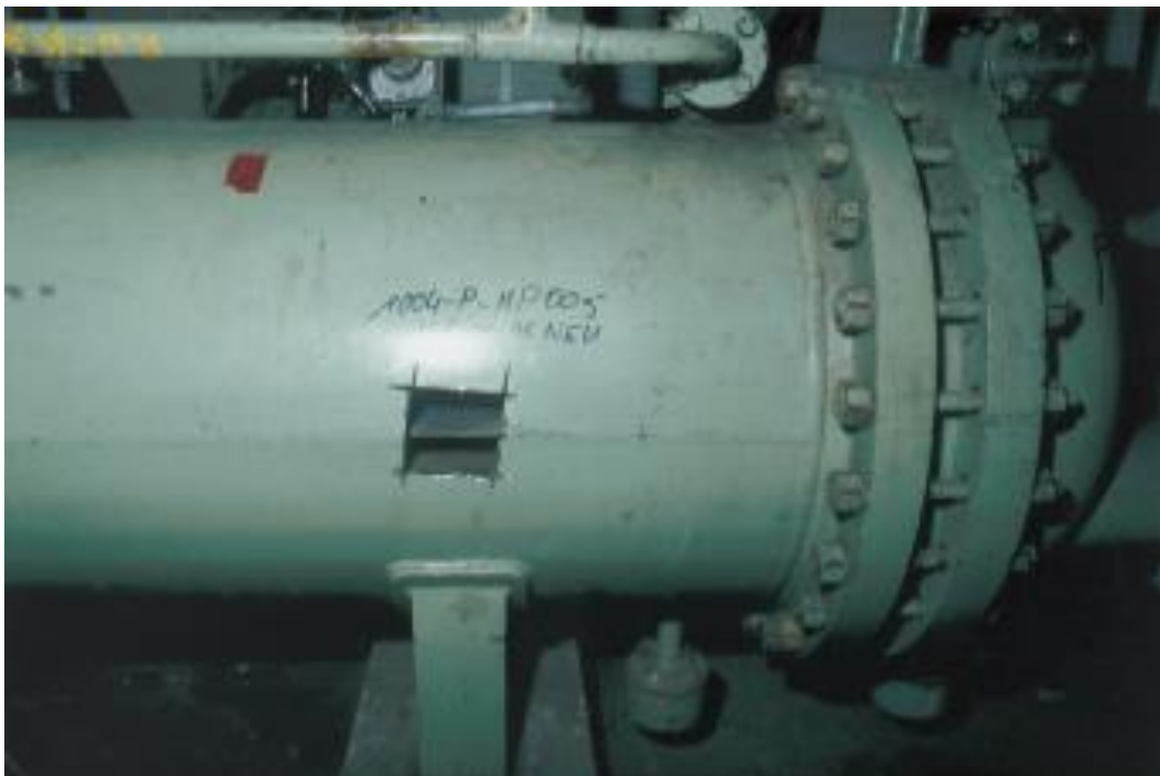
圖 2.2 德國 HDR 電廠從設備硬殼的主要組成部分切割樣品
