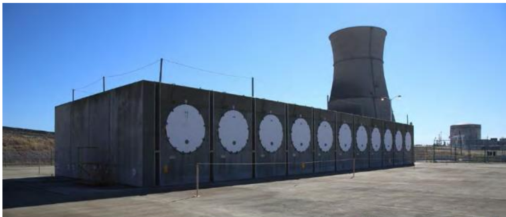
圖 3-9 Rancho Seco 電廠之 ISFSI
