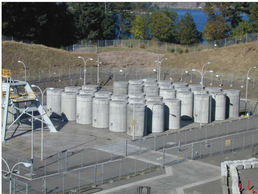
圖 3-6 Trojan 核電廠之 ISFSI
