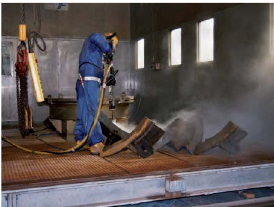
圖 3-3 高壓水噴射之除汙作業方式[15]
