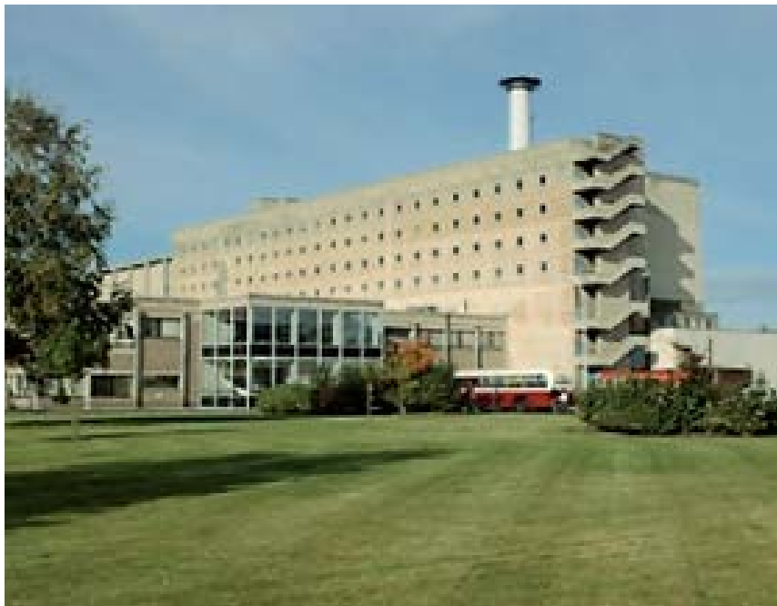
圖 4-1 核設施除役之前的情形[17]
