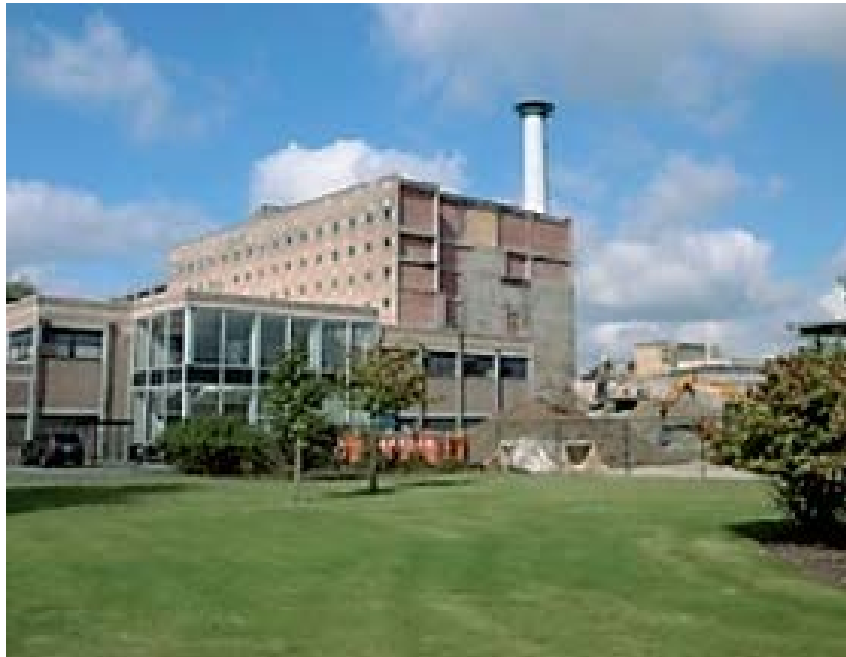
圖 4-2 拆除工作進行中的情形[17]
