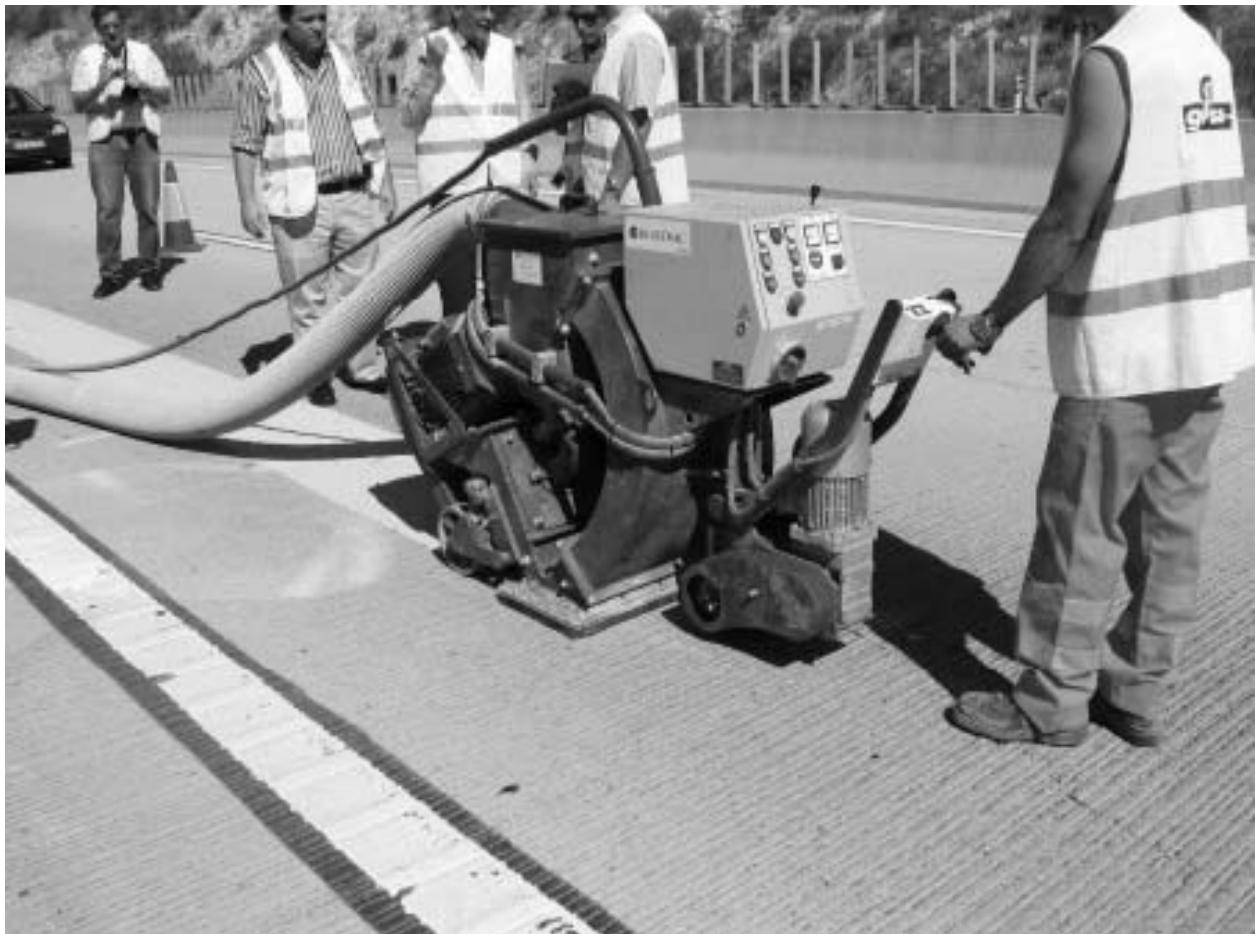
圖 3-5 於地板應用之研磨噴砂之商業化設施[11]
