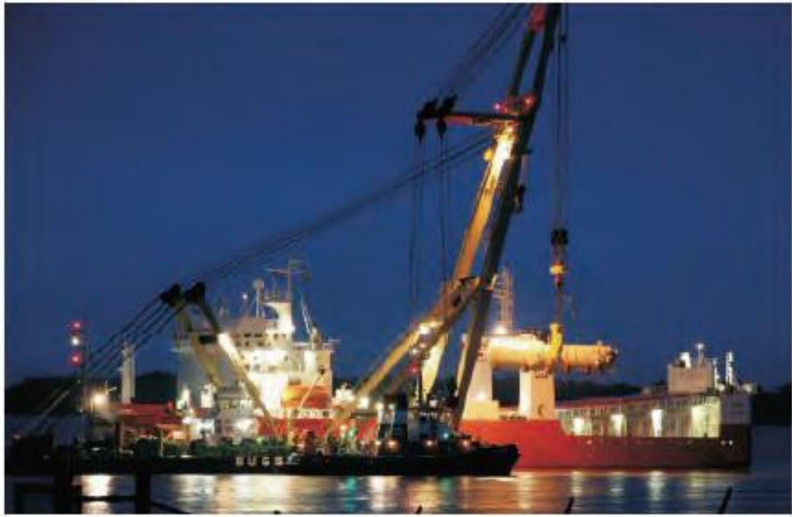
圖 4- 13 利用起重船將蒸汽產生器吊裝至運輸船 MS Sigyn 的作業
