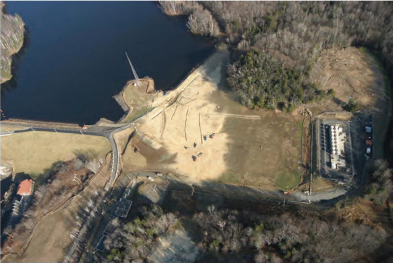
圖 4- 11 Yankee Rowe 發電廠廠址開放後的狀況
