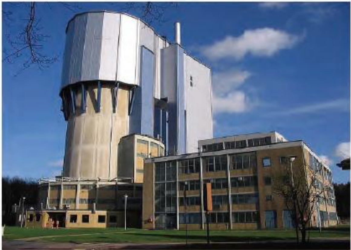
圖 4-16 藉由搬運建築擴充 AVR 原子爐建築
