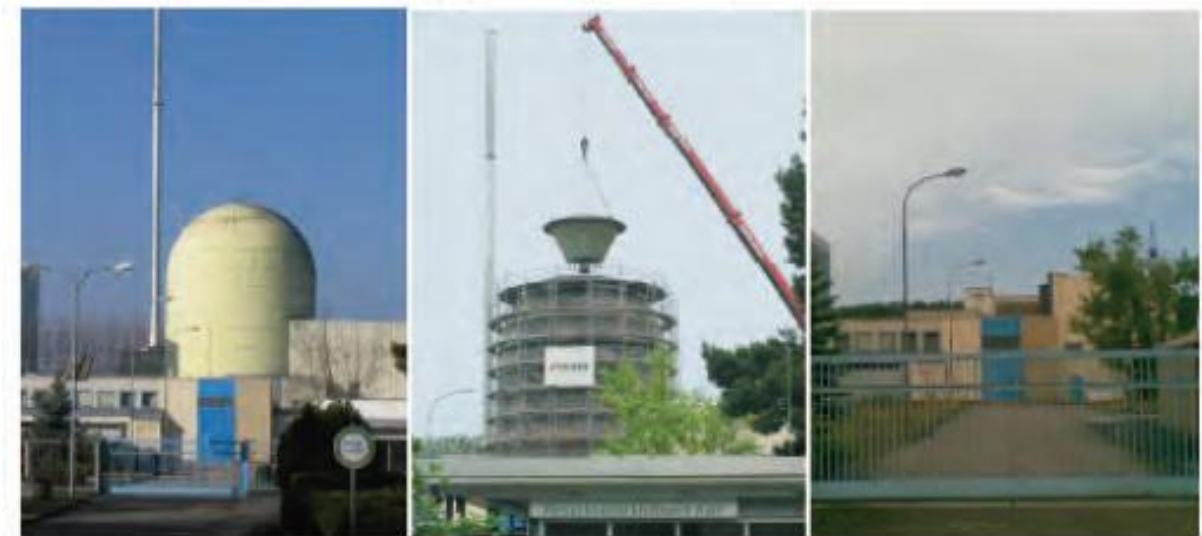
圖 4-14 Kahl 實驗用核能發電廠原子爐建築的依序解體景況
