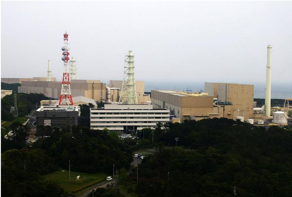
圖 3-11 中部電力濱岡核能發電廠 1、2 號機（ 2010 年 5 月）
