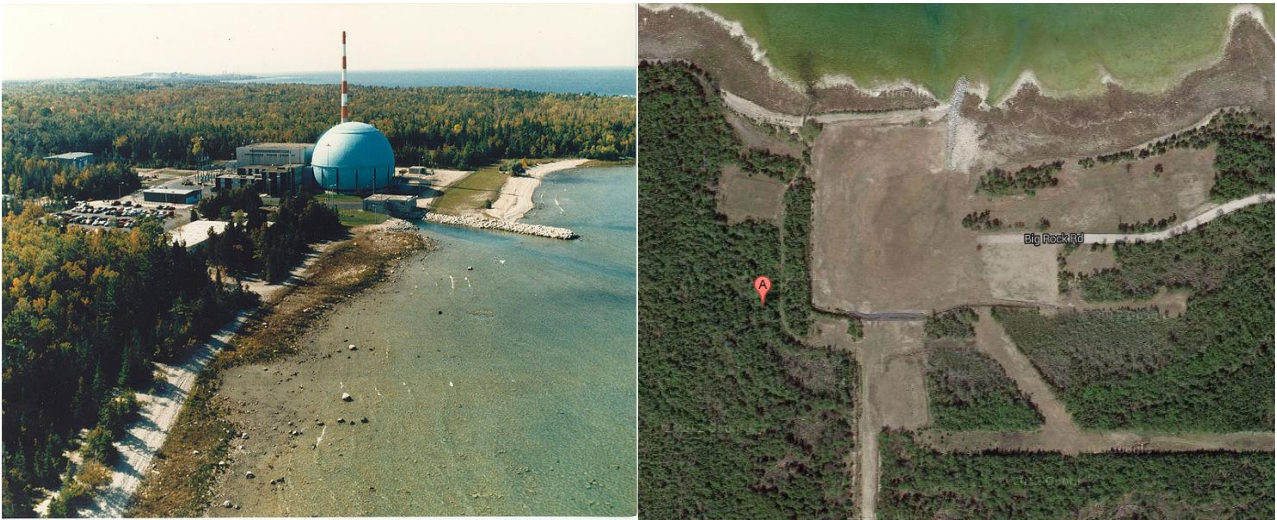
圖 3-1 Big Rock Point 核電廠（左：除役前之廠址，右：除役後之空照圖）
