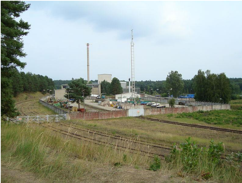
圖 3-5 Rheinsberg 核能發電廠除役後的照片（2010 年 8 月）
