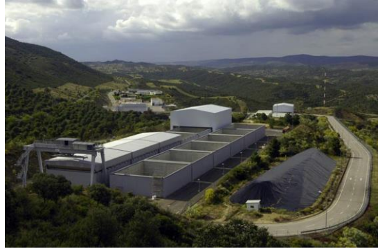
中階放射性廢棄物貯存掩埋設施
