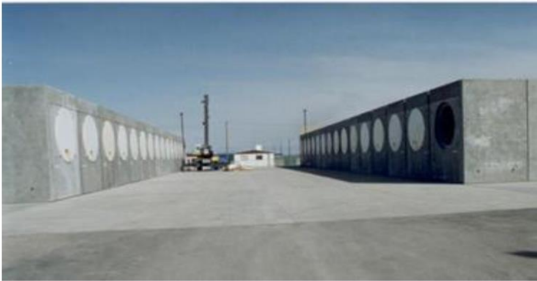
圖 24 TMI-2 事故中燃料碎片之保管系統 [69]
