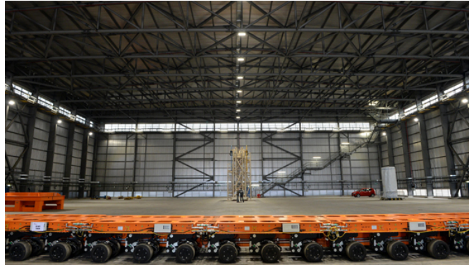
圖 5.1-11、英國 SIZE WELL B 電廠之鋼構室內乾貯廠房
