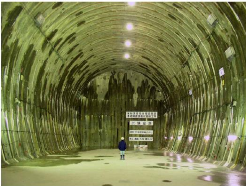
圖2.2-17 試驗空洞實際照片(寬約 18 m，高約 16 m)(日本原燃株式会社，2006)
