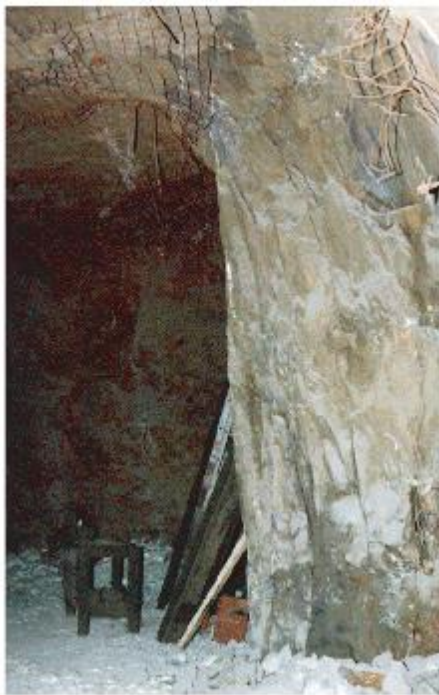
圖2.3-5 於高應力作用之硬岩區進行坑道開挖引致之母岩損傷：(a) AECL在URL進行的MBE試驗，圓形坑道斷面開挖後產生剝落現象、(b)採礦工程採用馬蹄型坑道斷面，除了頂拱外，易在底拱與側壁轉角處觀察應力集中與岩體損傷(SKB, 2001; Siren, 2015)
