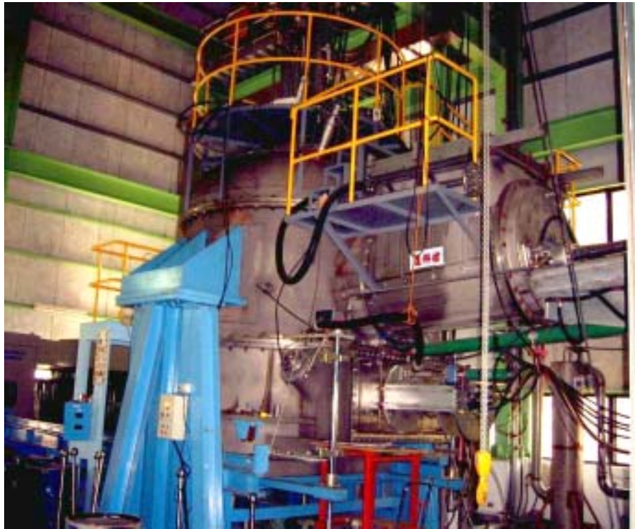
圖 3-6 核能研究所非放射性先導型電漿焚化熔融爐外觀照片
