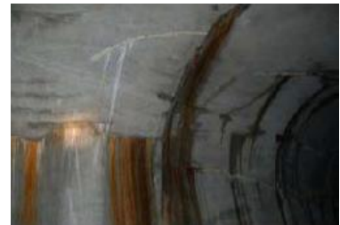
起拱線附近平行縫與上方斜裂縫
