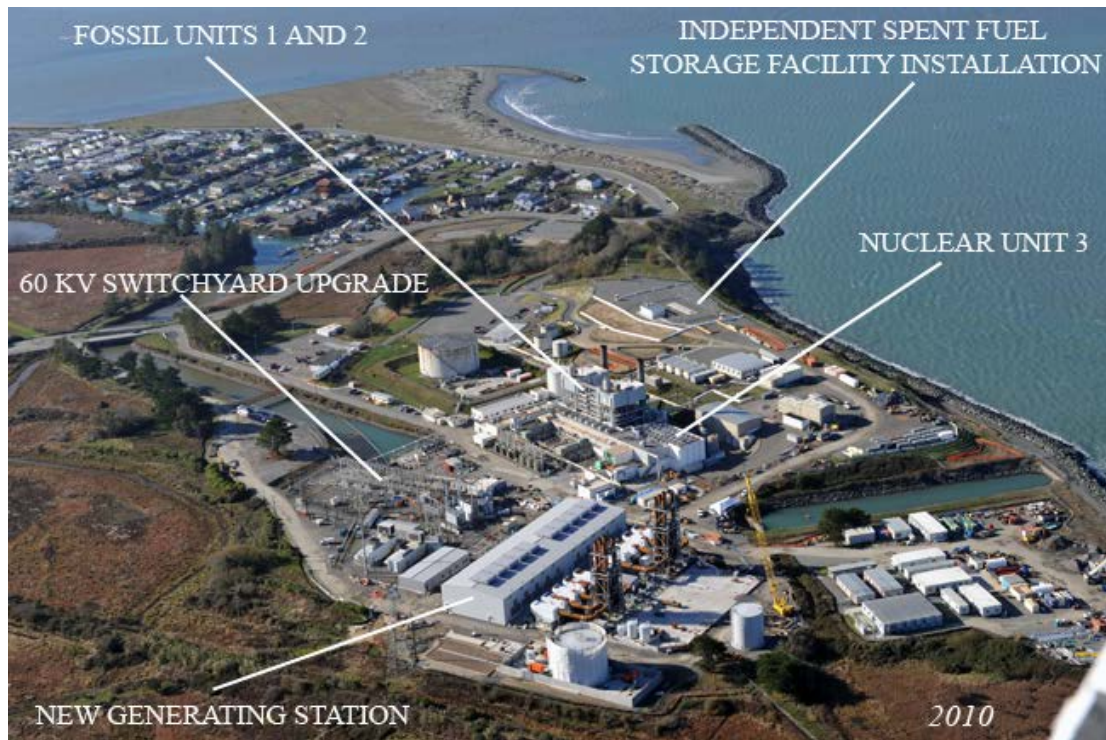
圖二、美國 Humboldt Bay 發電廠(攝於 2010)。(K. Rod et al , WM2015 Conference, March 15 – 19, 2015, Phoenix, Arizona USA)
