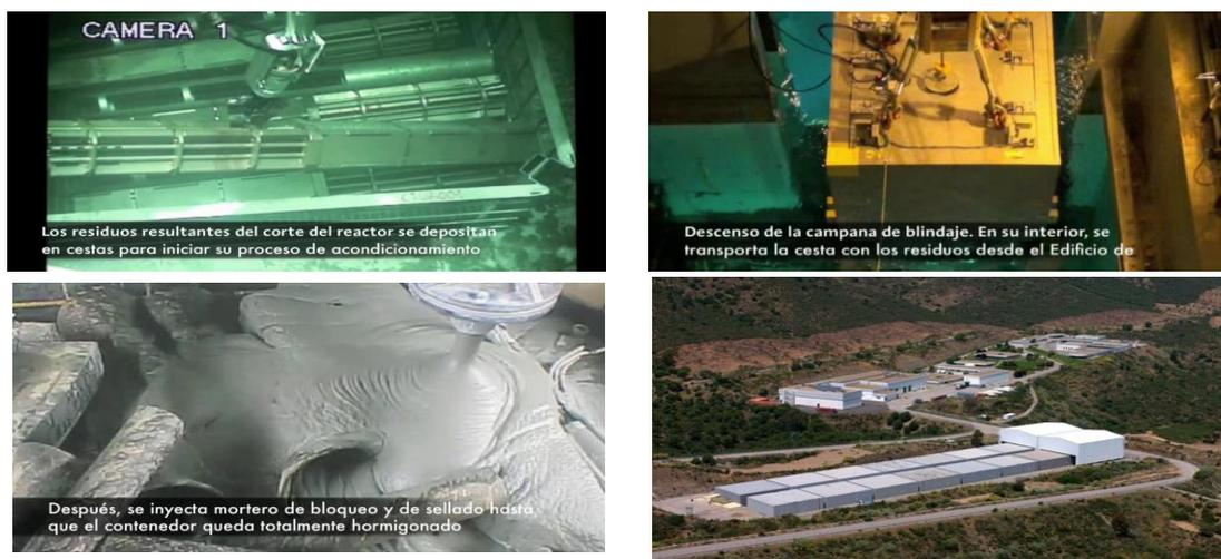
圖 二十二、Zorita 核能電廠之低階放射性廢棄物後續裝載容器與處置
