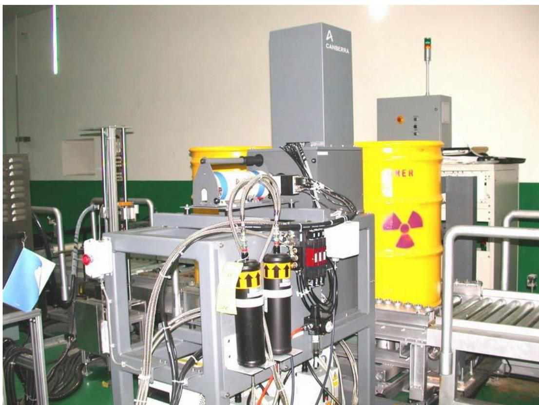
圖 7.2.5-2、核研所三貯庫廢棄物整桶加馬能譜計測設備
