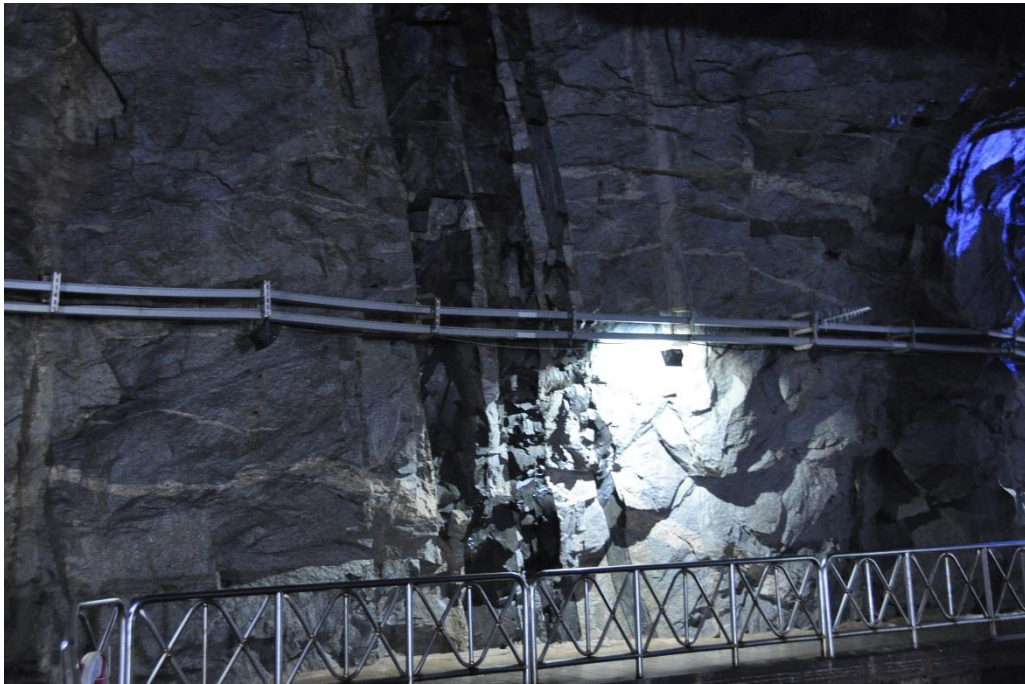
圖4.2-11 翟山坑道側壁之基性岩脈群(2)
