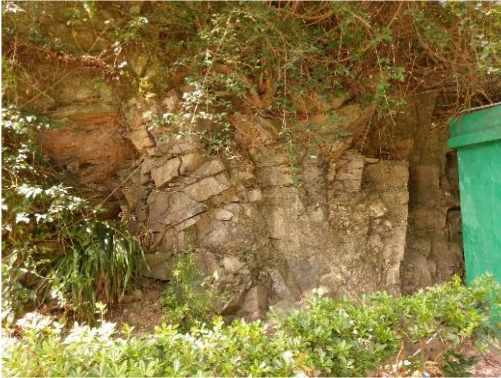
圖4.2-4 翟山坑道入口處地質現況
