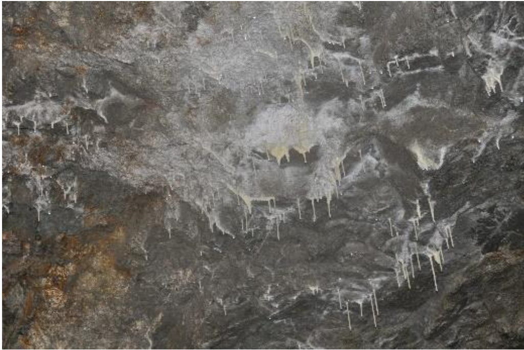
圖4.2-13 翟山坑道頂拱處局部基性岩脈地下水入滲
