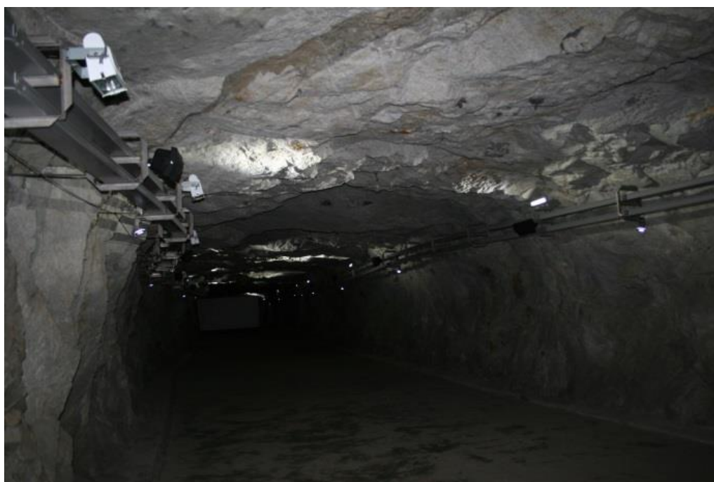
圖4.2-9 翟山坑道坑道段之地質現況
