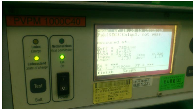
圖 2-8：PVPM 發電效率測量系統
