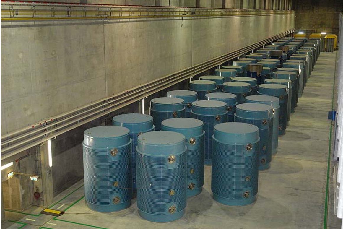
圖 3.3.1 德國 Greifswald 電廠乾式貯存設施
