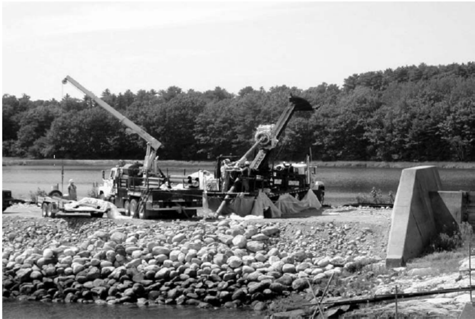
圖 3-25 Maine Yankee 沉澱前池 - 圍堤岩芯抽樣
