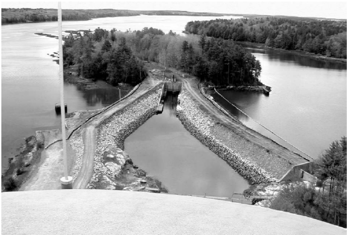
圖 3-23 Maine Yankee 沉澱前池 – 尚未整治前
