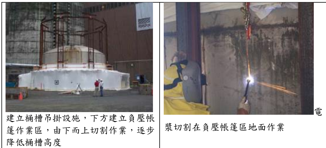
圖 6-3 燃料裝填水儲存槽拆除作業
