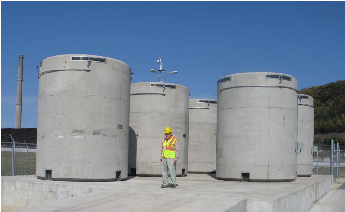
圖 3.1.5 美國 La Cross 電廠乾式貯存設施
