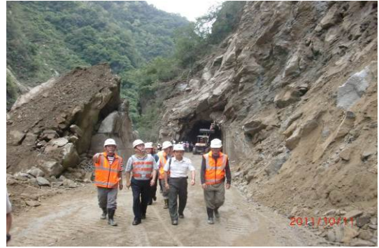
圖 3.4-7 中部橫貫公路某隧道受邊坡失穩而破壞，災前(左)與災後(右)照片
