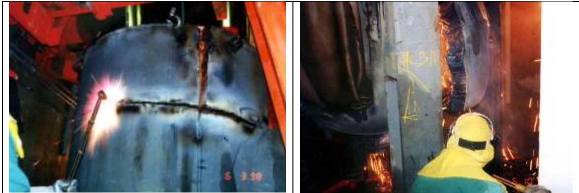
圖 6-1 由上往下切割，採用火炬切割
