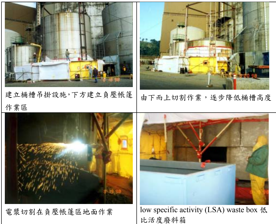
圖 6-2 一次側爐水儲存槽拆除作業
