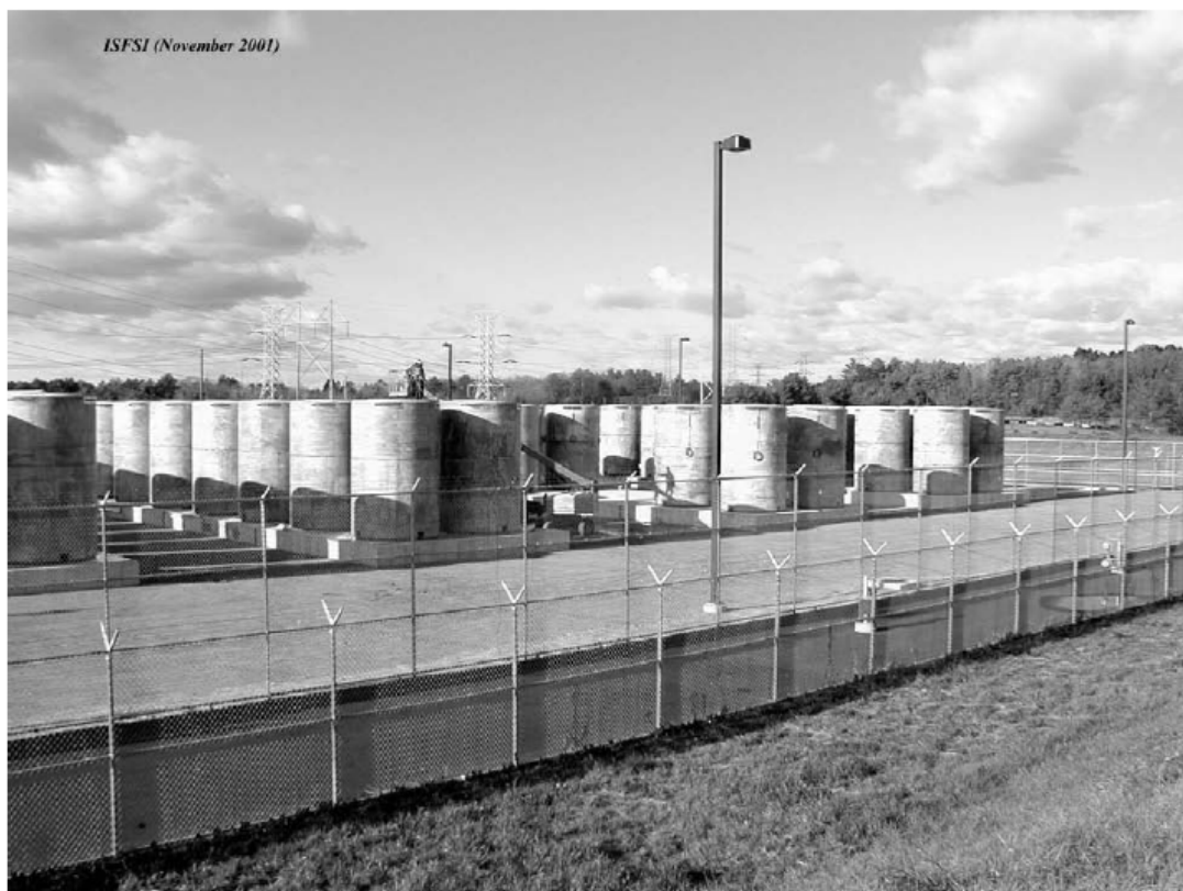
圖 3-10 Maine Yankee ISFSI 墊及乾式貯存筒
