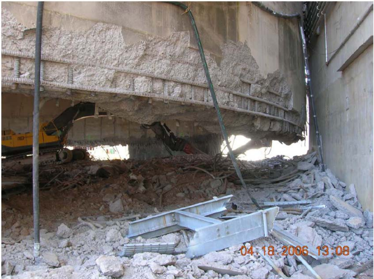
圖 4-12 第一次下降前從腳支柱內側移除混凝土
