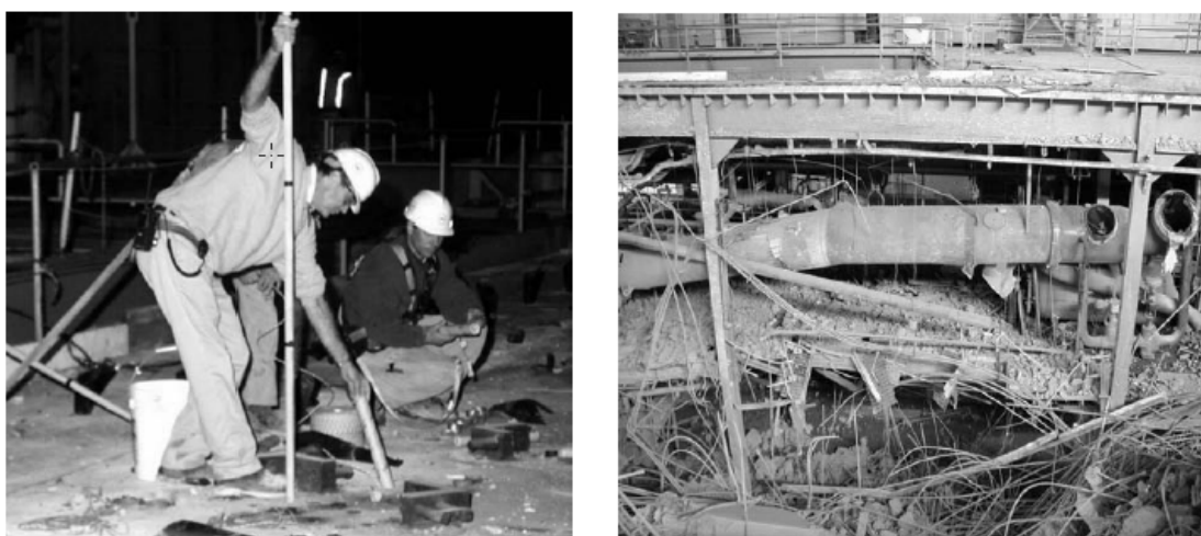
圖 3-16 Maine Yankee 汽機柱腳炸藥放置後爆破
