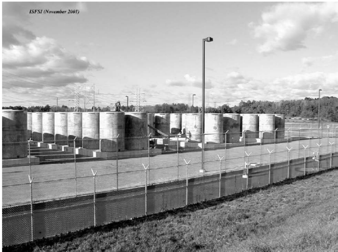
圖 3-10 Maine Yankee ISFSI 墊及乾式貯存筒
