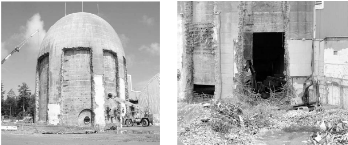
圖 3-19 Maine Yankee 圍阻體拆除準備
