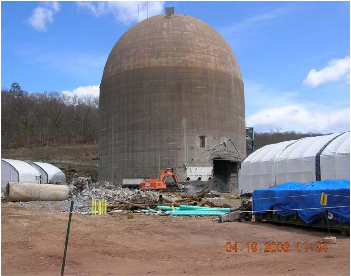
圖 4-11 第一次下降前用液壓撞擊鉗移除腳支柱
