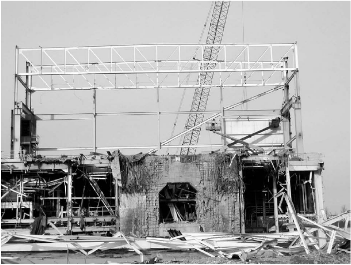
圖 3-17 在爆破之拆除後的 Maine Yankee 汽機廠房
