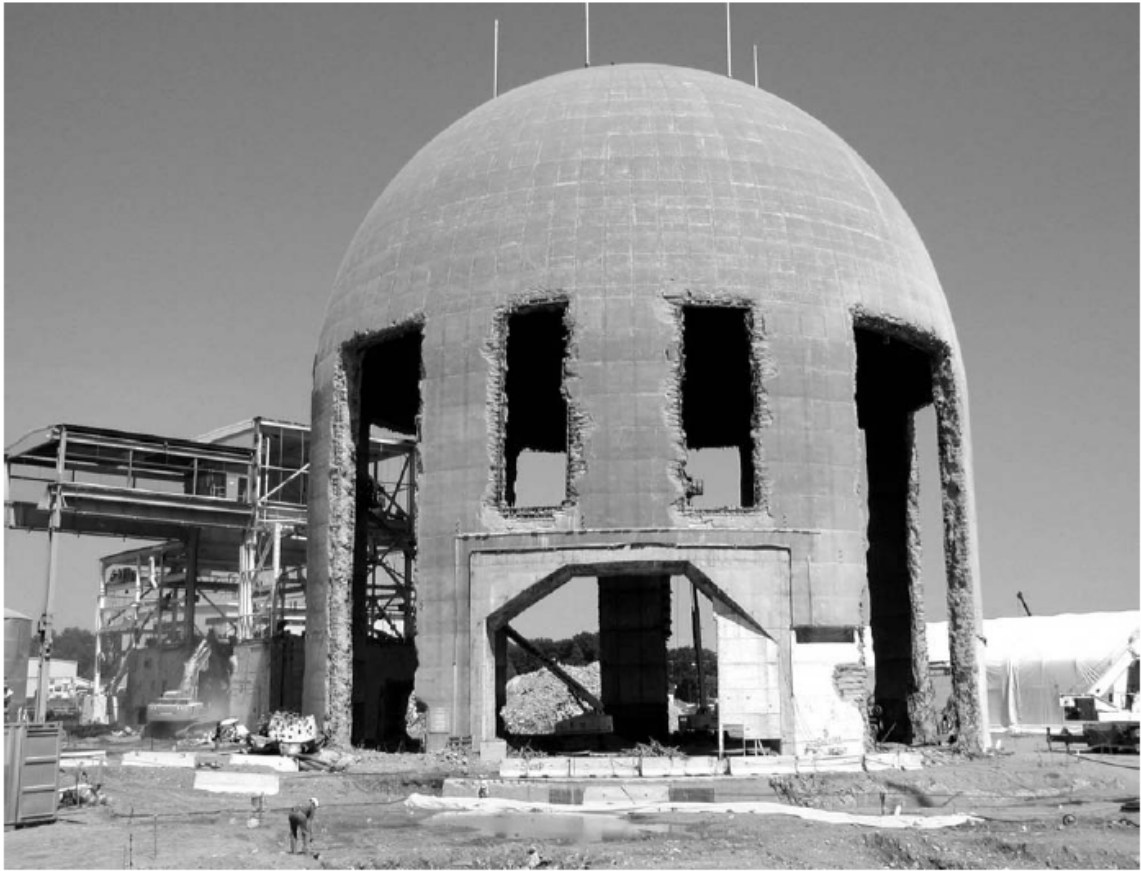
圖 3-20 Maine Yankee 圍阻體已準備好進行拆除
