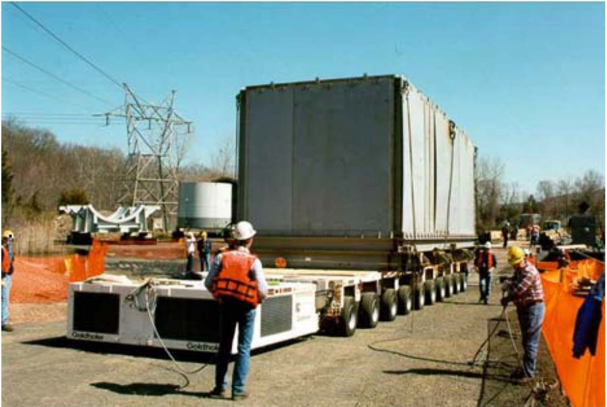
圖 4-6 移動蒸汽產生器下端組件至駁船滑台
