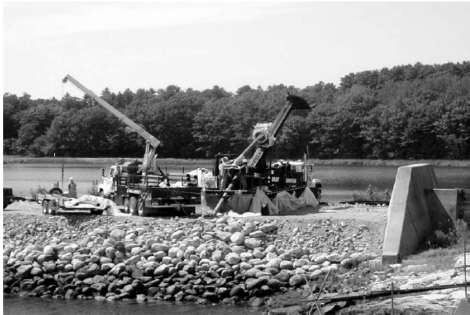
圖 3-25 Maine Yankee 沉澱前池 - 圍堤岩芯抽樣
