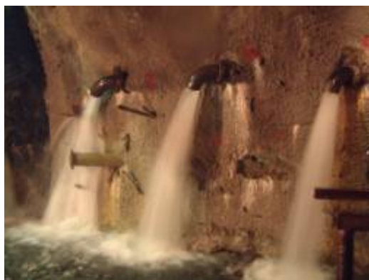
圖 4-30 大口徑排水洩水降壓(摘自[11])
