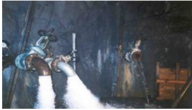
圖 4-28、水平長距離鑽探作業孔口出水情形(摘自[11])
