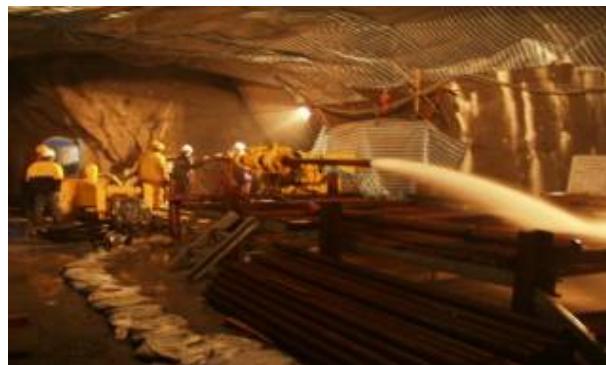
圖 4-27 水平長距離鑽探作業(摘自[11])
