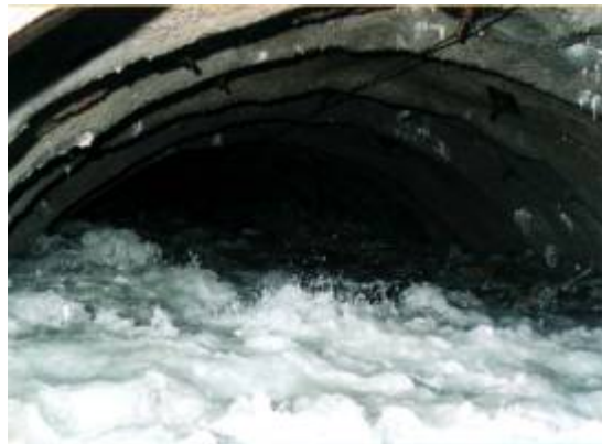
圖 4-25 新永春隧道湧水情形(摘自[10])
