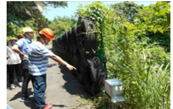
邊坡監測系統
