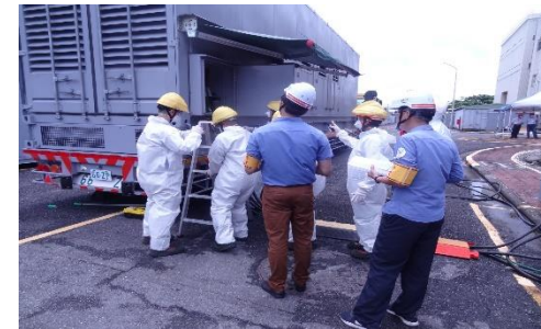
廠內移動電源車 (4.16kV) 連接演練
