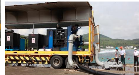
移動式第二熱沉佈線 引接及抽海水演練
