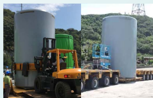
混凝土護箱移動演練
