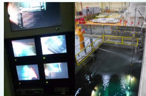
用過燃料池內作業用 設備之組裝演練
