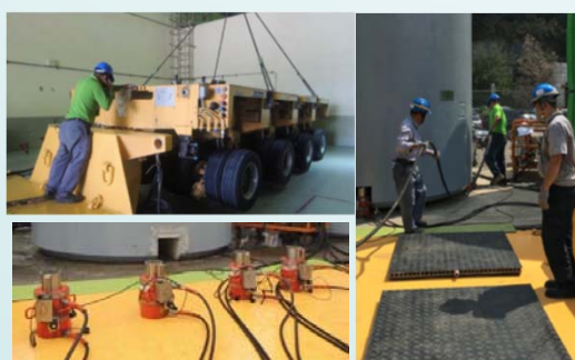
多軸油壓板車、懸浮氣墊組 及液壓千斤頂系統組裝測試
