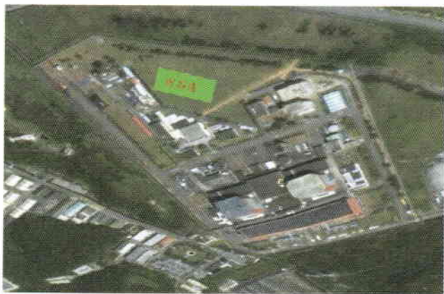
核二廠用過核子燃料乾 式貯存場址現況
