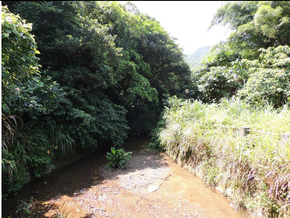
照片 02-10-4 A 排水渠道在進入核二廠區前，經過整治的溪床
