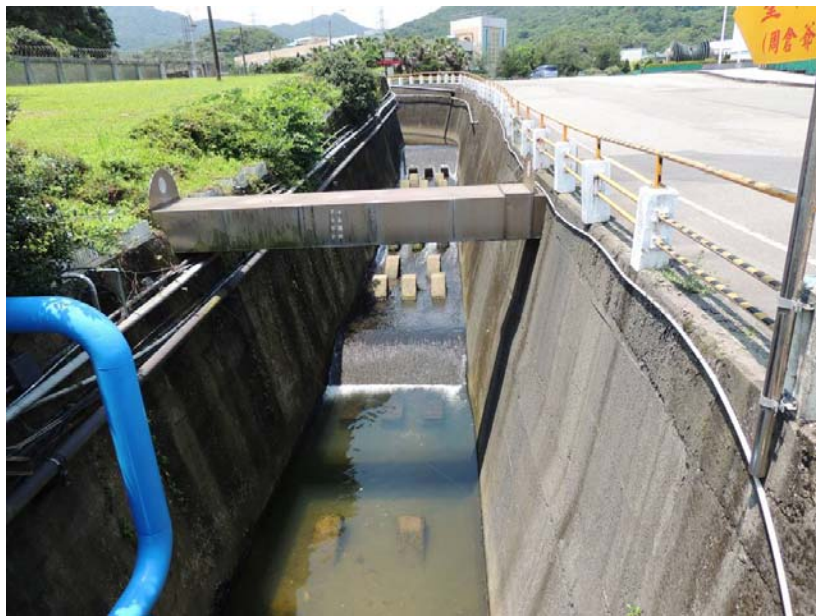
照片 02-28-1 A 排水渠道流出廠區處斷面
