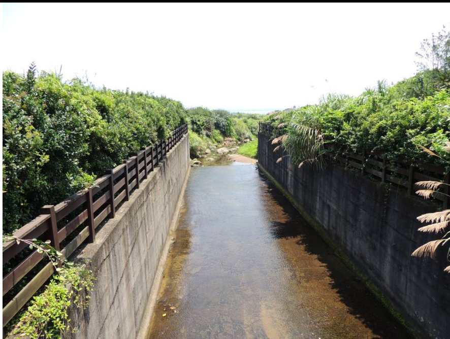
照片 02-28-2 A 排水渠道出口處斷面
