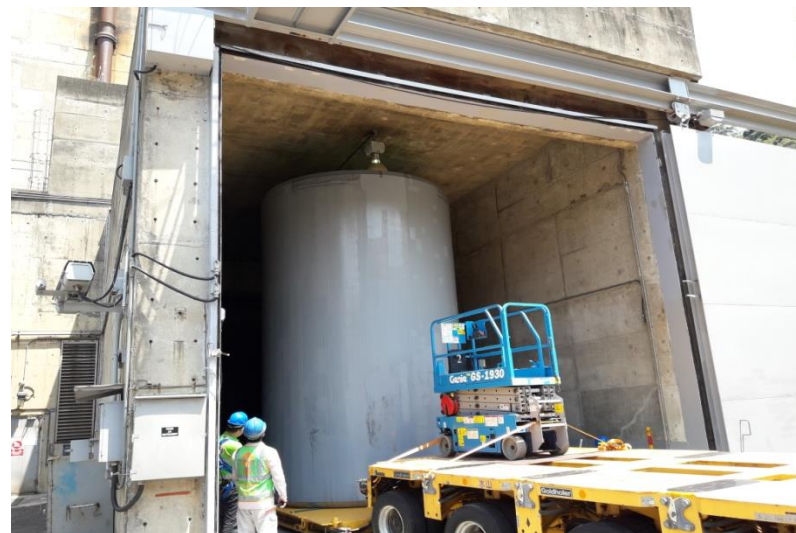
混凝土護箱運入反應器廠房
