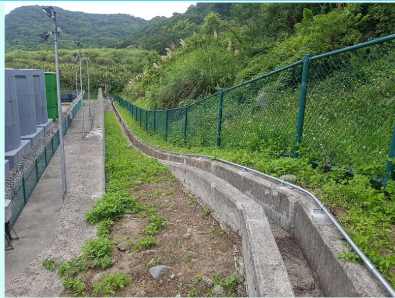
全系統管線重新配置
