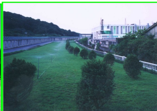
3、4 號廢料倉庫除役後
