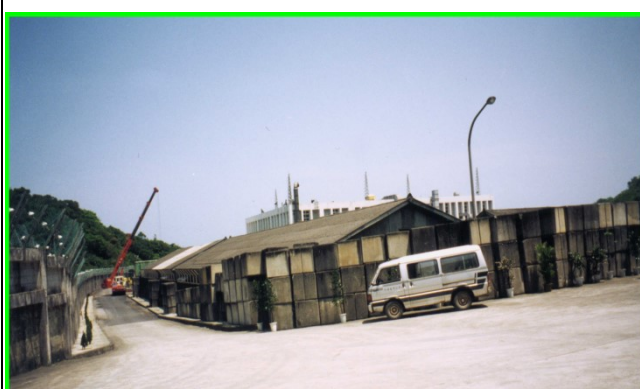
3、4 號廢料倉庫除役前
