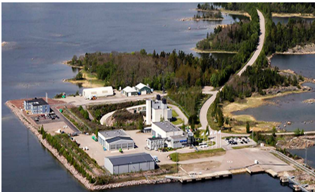
圖 1 SFR 處置場地表設施現況
