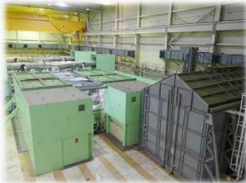
汽機廠房3樓現況
