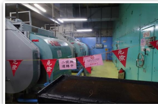
共用區域2號機設備之保護
