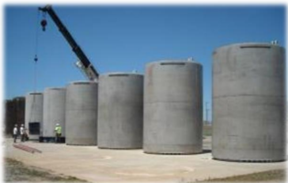
室外混凝土護箱(美國)
