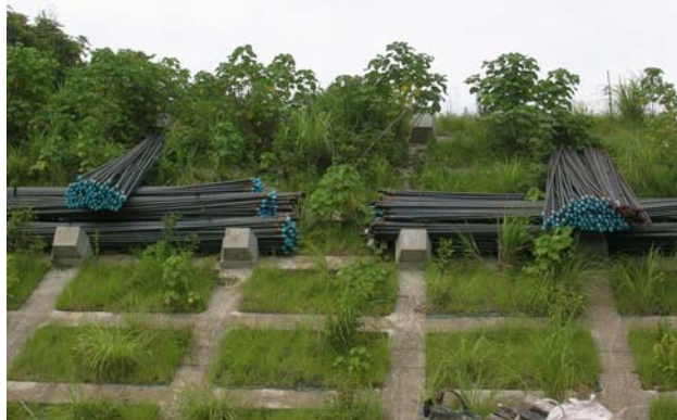
圖一 低放射性廢棄物貯存庫工地旁鋼筋斜放於擋土牆上
