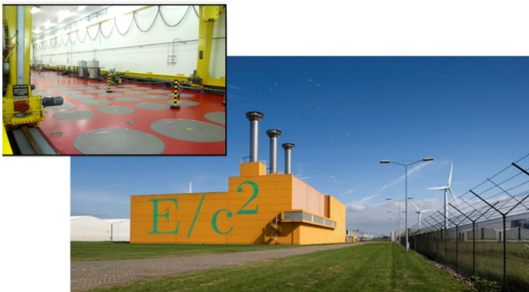
圖 6 COVRA 高放射性廢棄物貯存設施-HABOG
