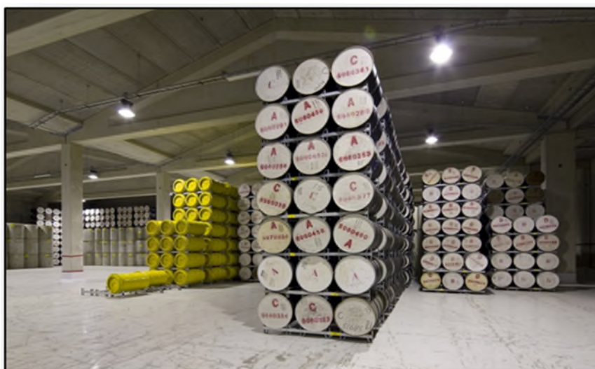
圖 5 COVRA 中、低放射性廢棄物貯存庫內部貯存配置
