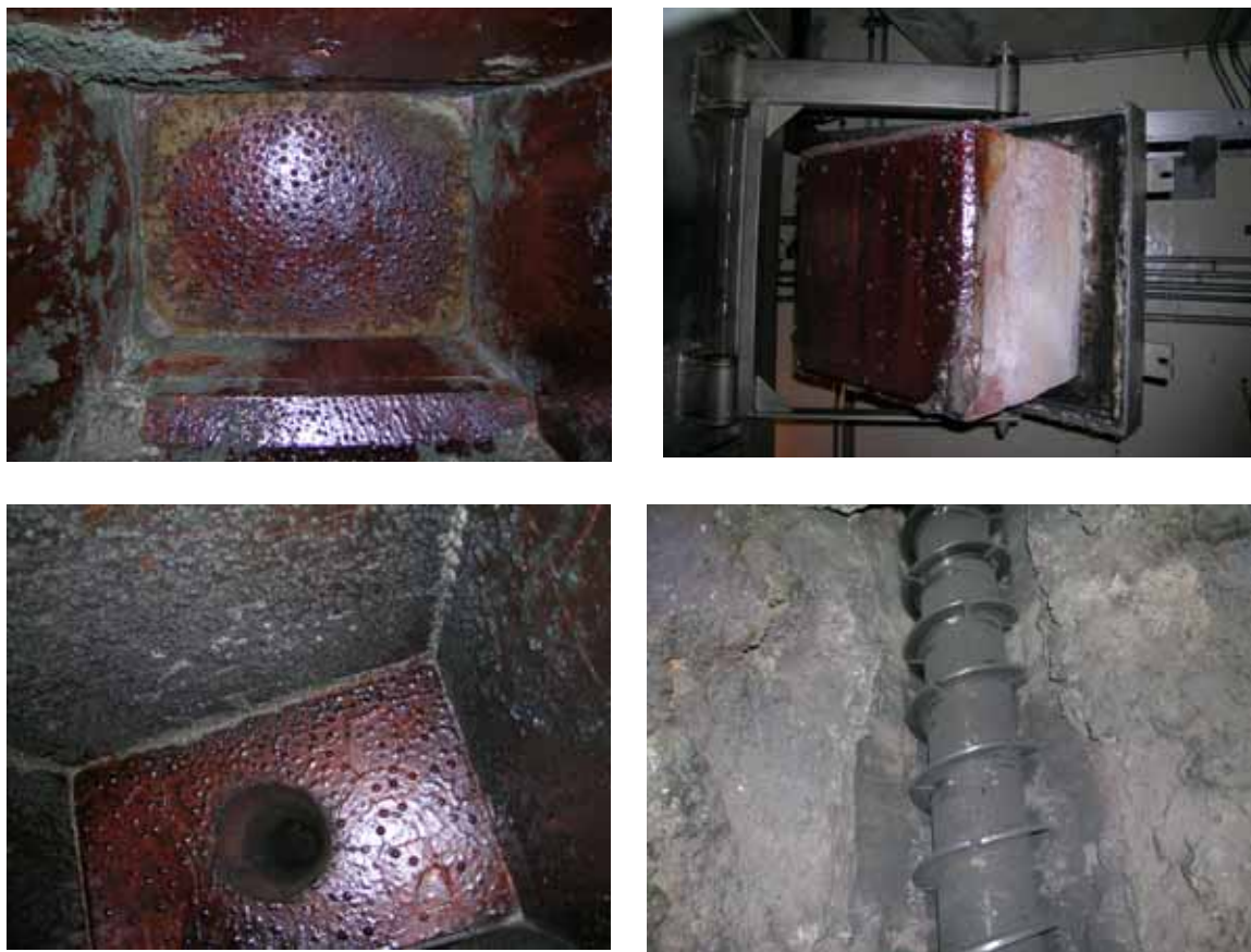
附圖三~六 焚化爐內部檢查狀況
