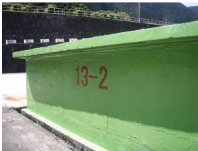
圖一 原先膠膜與防水漆未塗補之部分已改善
