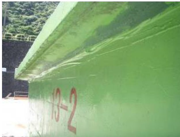
圖二 壕溝蓋板下方已塗防水漆
