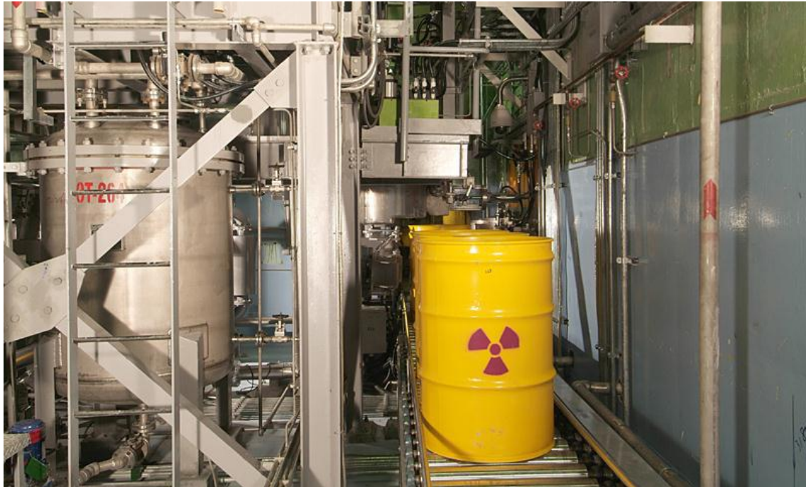
圖 4-1 核二廠高減容固化系統
