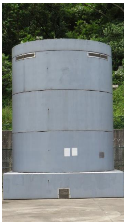
圖2-2 乾貯護箱(INER-HPS)外觀圖
