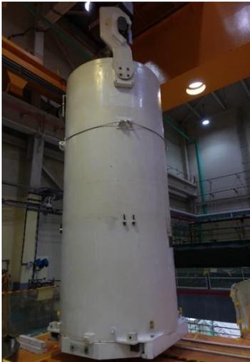
圖 3-7 TFR 吊回五樓防震架(TSC-05)
