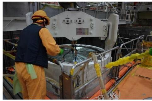
圖 3-32 使用手持式排水泵進行排水(TSC-06)
