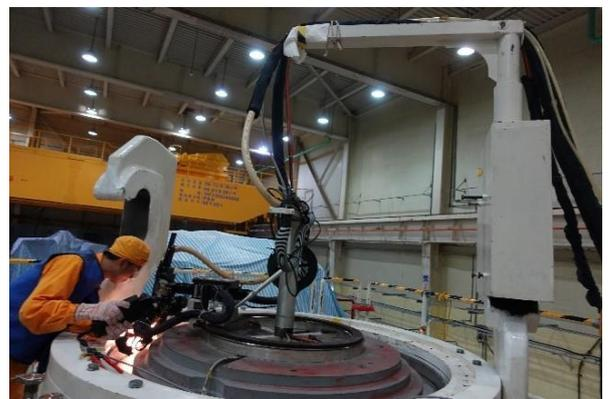
圖 3-36 屏蔽上蓋銲接過程調整作業(TSC-05)
