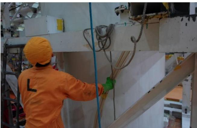
圖 3-17 安裝環形間隙循環水系統(TSC-05)
