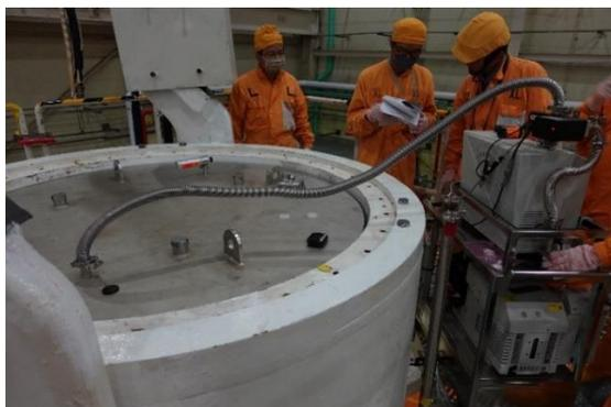
圖 3-51 氮氣測漏作業(2) (TSC-05)
