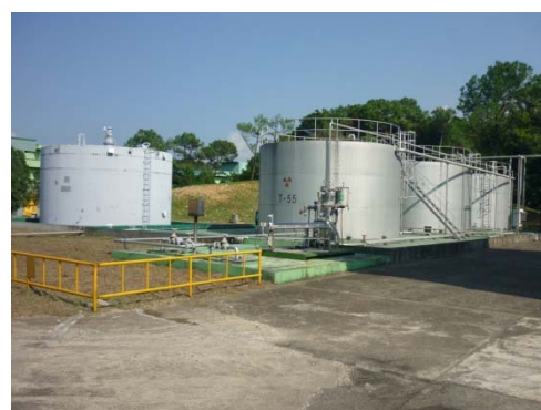
圖 6 015B 低放廢液貯存槽
