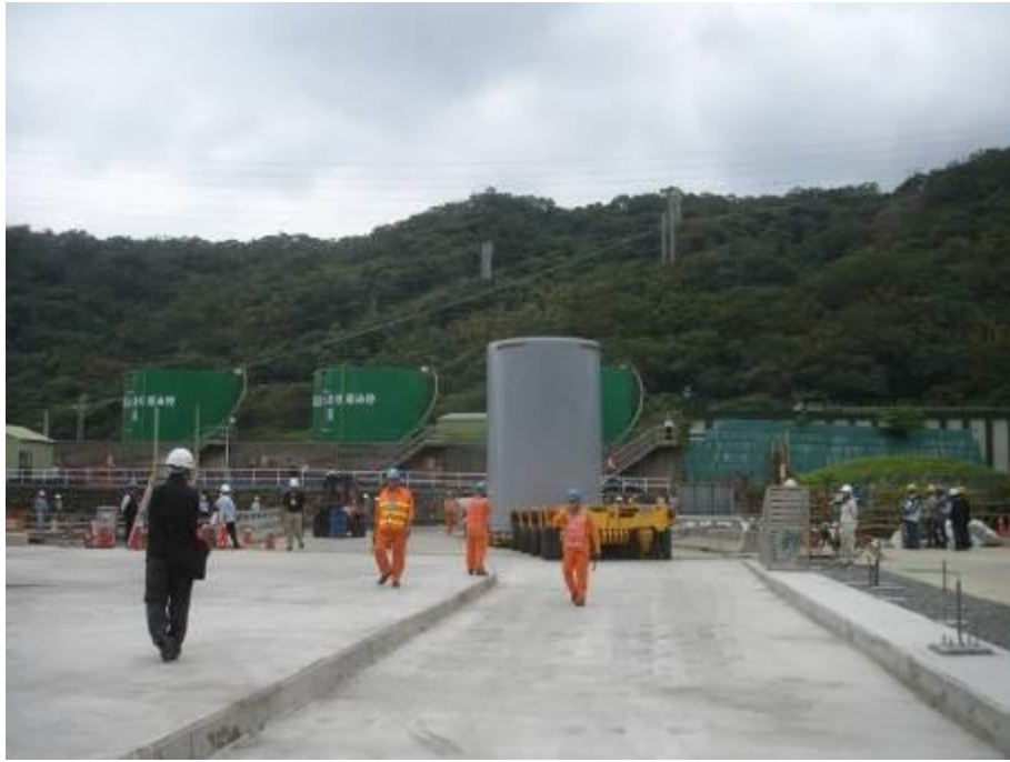
圖 3.2.61 混凝土護箱通過乾華橋
