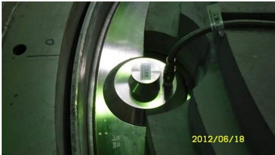
圖 3.1.5 氫氣偵檢與氫氣沖流系統於排水孔側管路特寫
