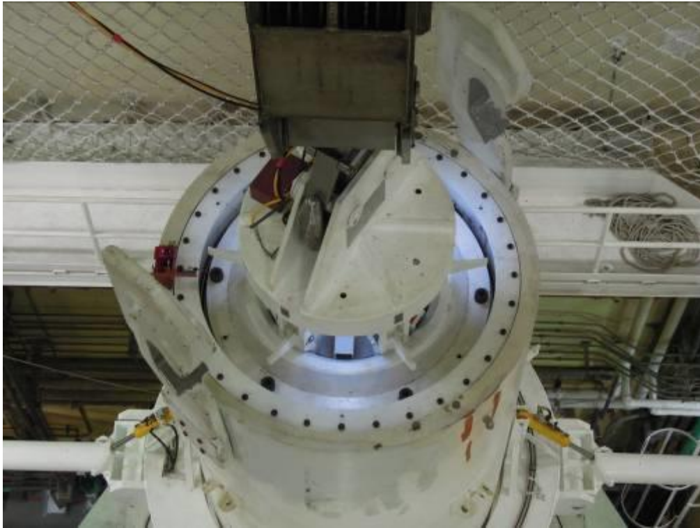
圖 3.2.47 將密封鋼筒吊入傳送護箱內
