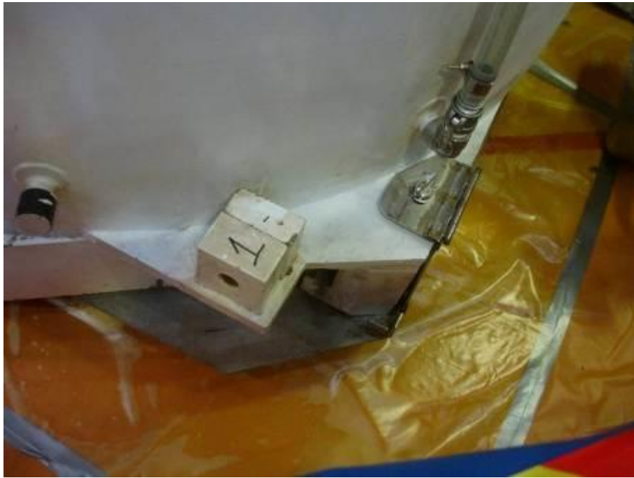
圖 3.3.1 傳送護箱底部防污板安裝完成貌
