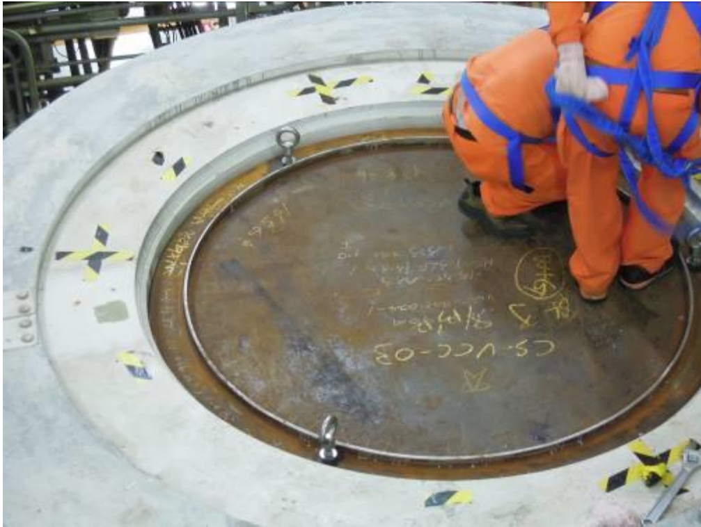
圖 3.2.41 準備將 VCC 之屏蔽塞吊離
