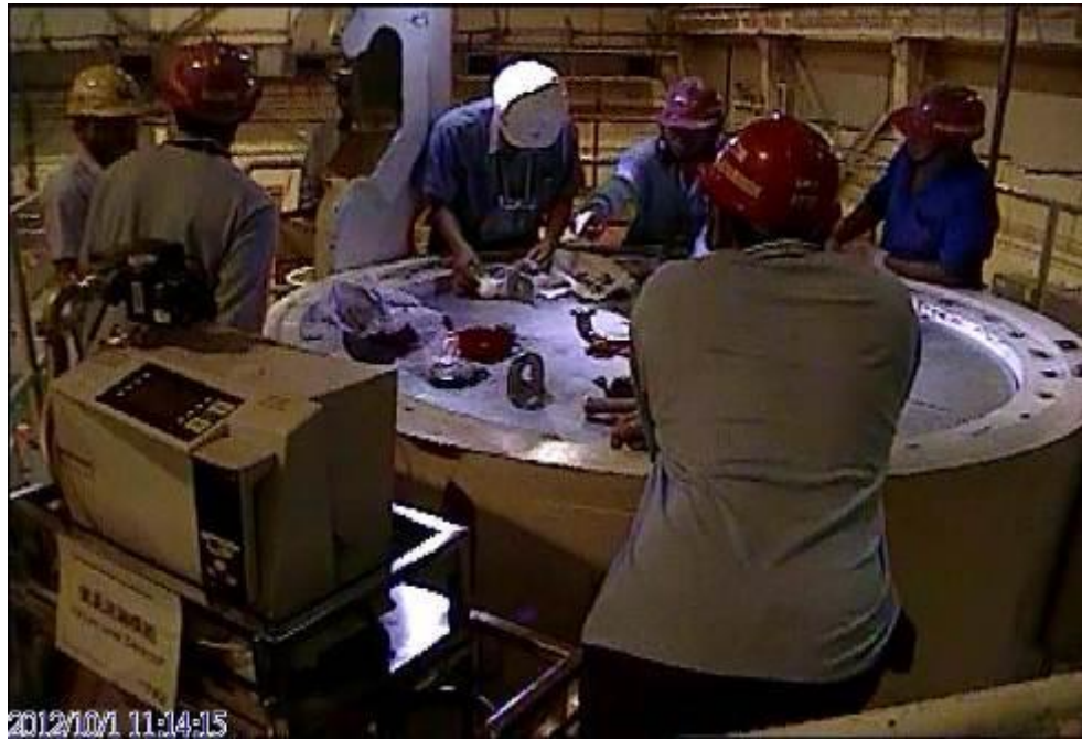
圖 3.2.21 安裝氮氣測漏儀
