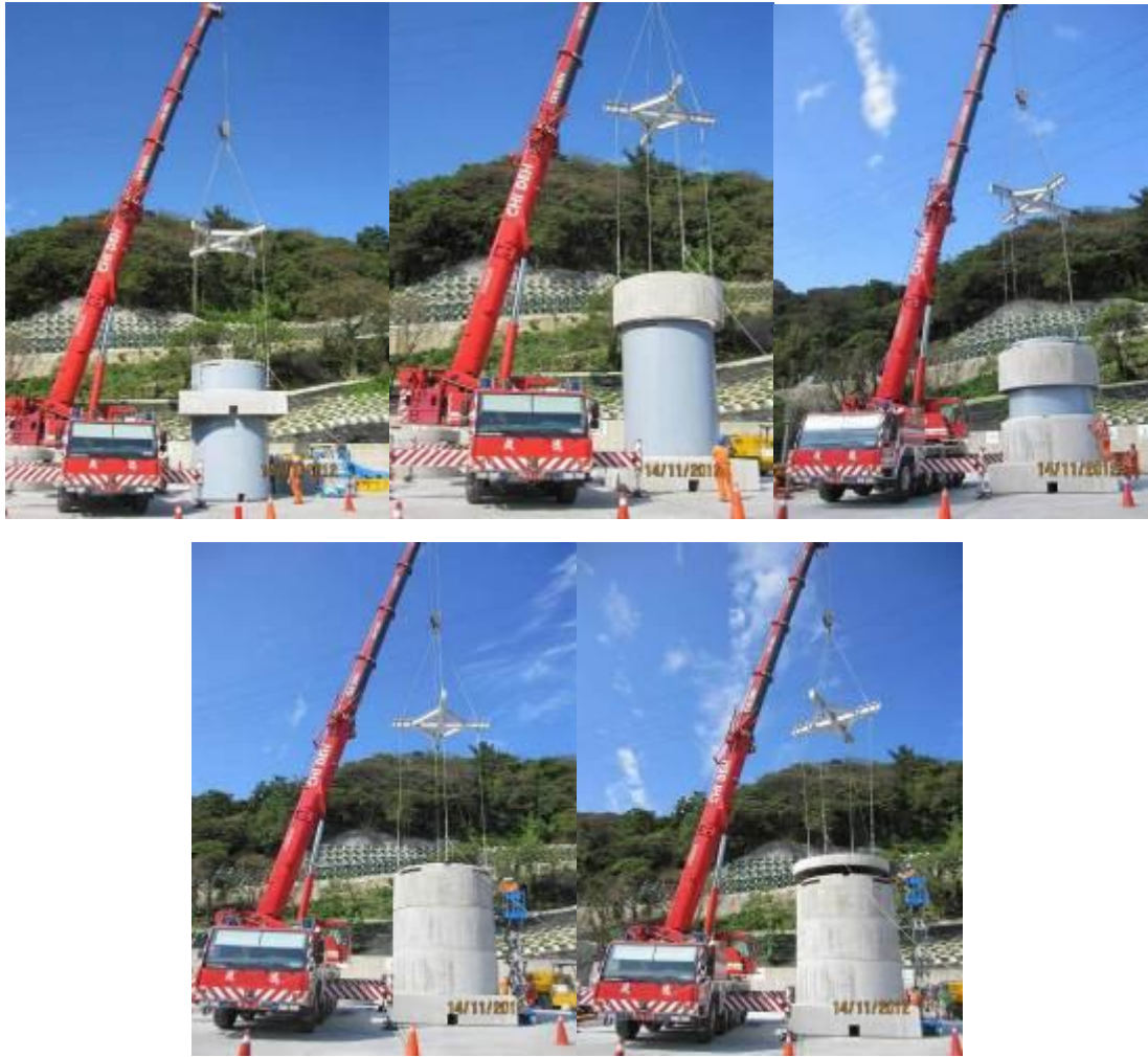
圖 3.2.65 安裝外加屏蔽之連續照片
