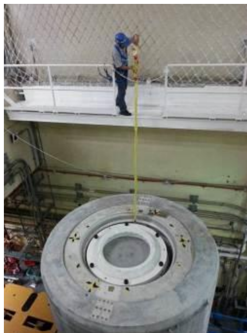
圖 3.2.34 進入 VCC 頂部作業前，量測 VCC 與鋼筒間間隙劑量率
