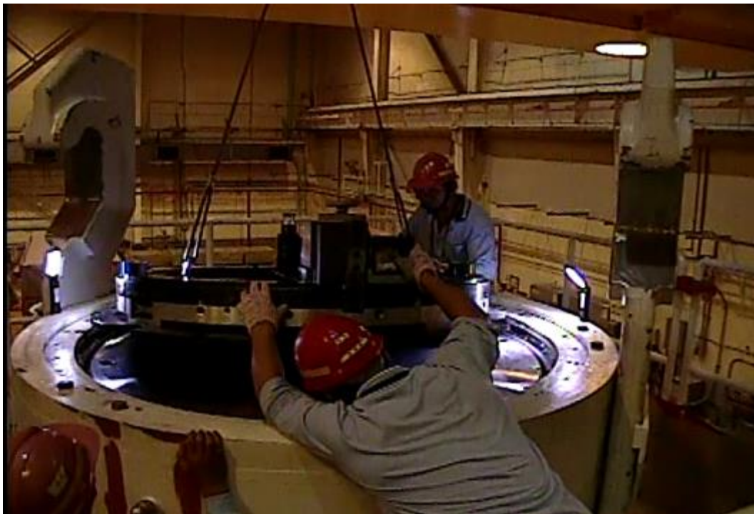
圖 3.2.50 銲道切除裝置安裝於結構上蓋上
