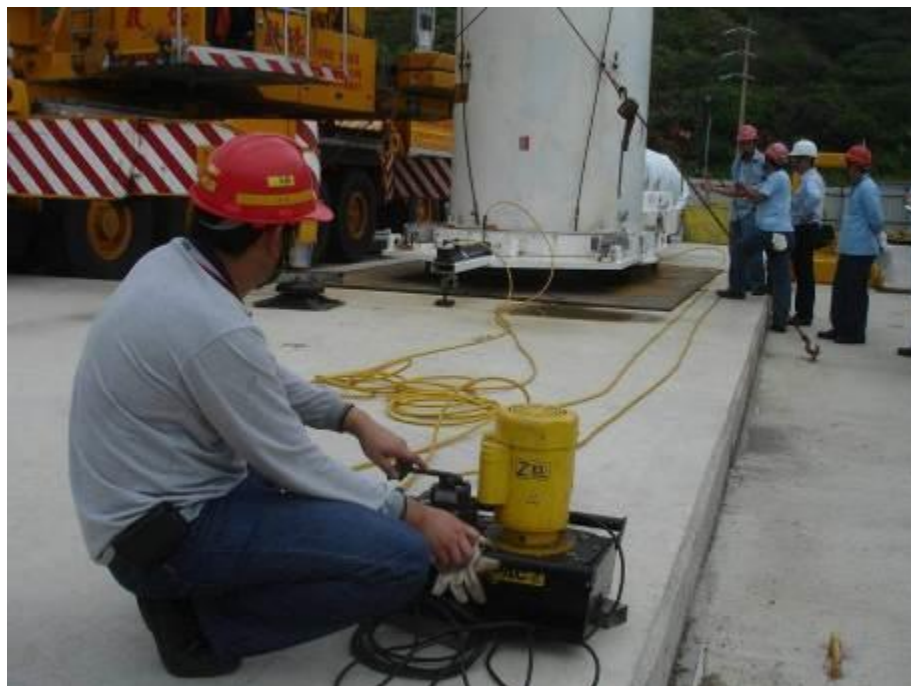
圖 3.2.3 以油壓系統開關屏蔽門
