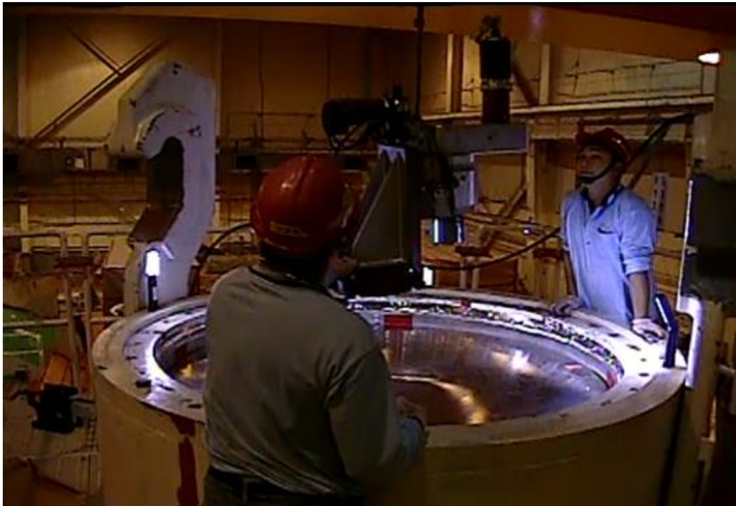
圖 3.2.52 孔蓋鐸道移除裝置安裝
