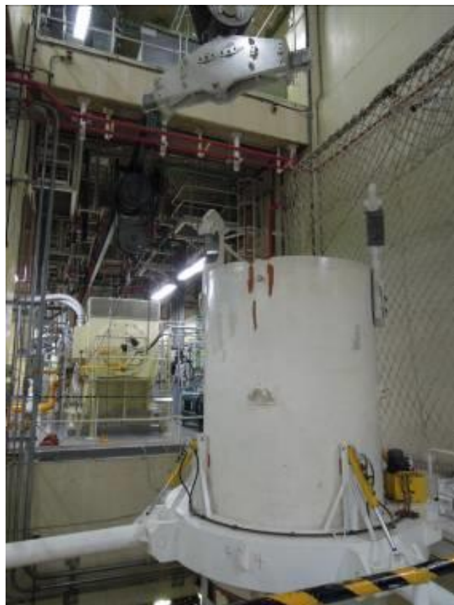
圖 3.2.48 準備以吊軌將傳送護箱吊至 5F
