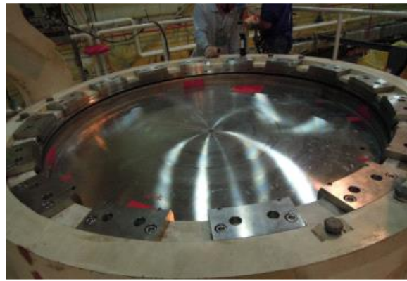
圖 3.3.3 傳送護箱頂部安裝上水密封機構前後
