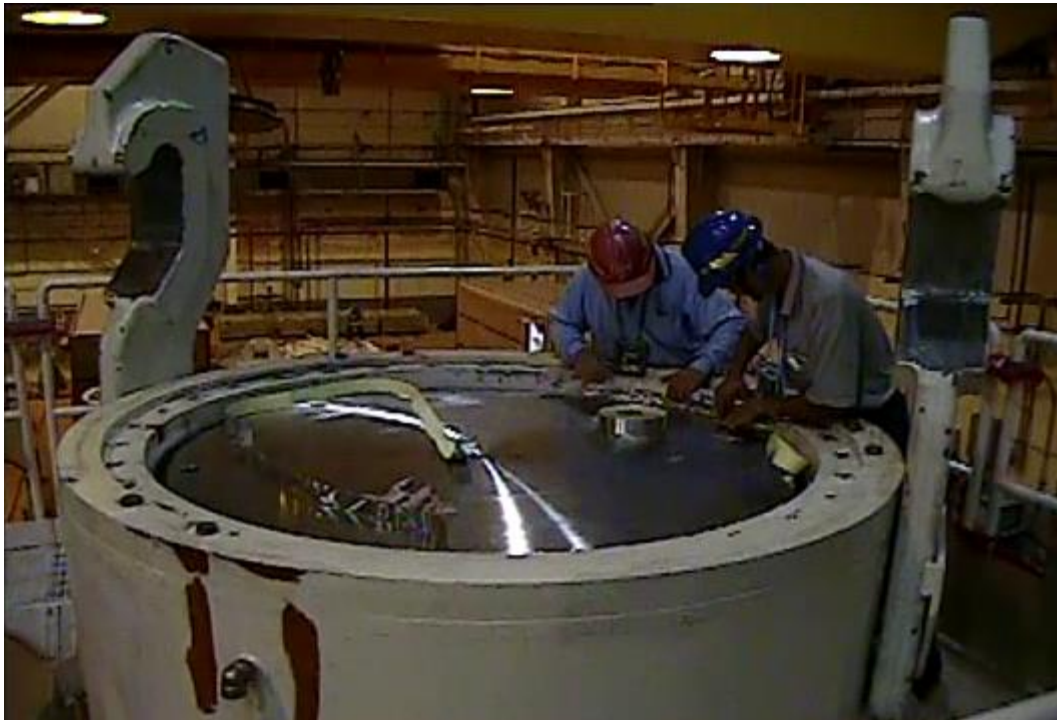
圖 3.2.49 利用金屬膠帶將間隙填補
