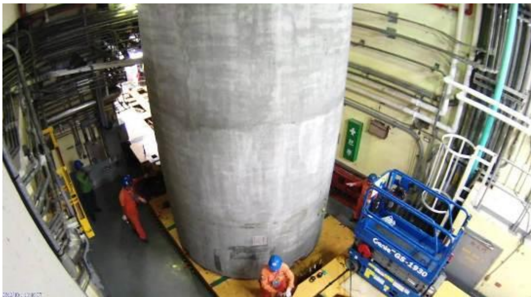
(b) VCC 於反應器廠房一樓天井下方定位
