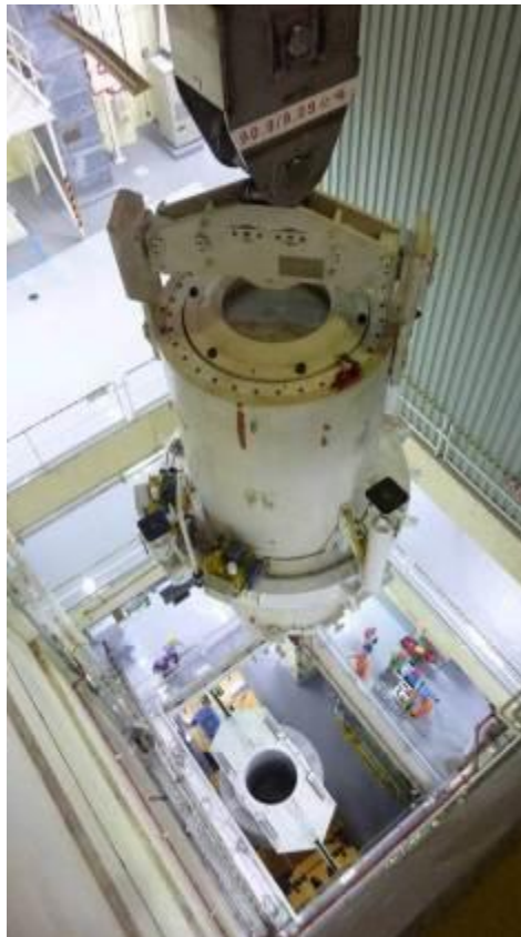
圖 3.2.28 傳送護箱穿越天井往 VCC 吊運
