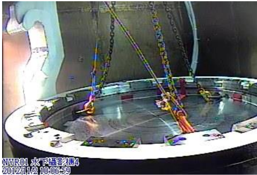
圖 3.3.13 觀察鋼筒內壁標示確認上蓋坐妥定位
