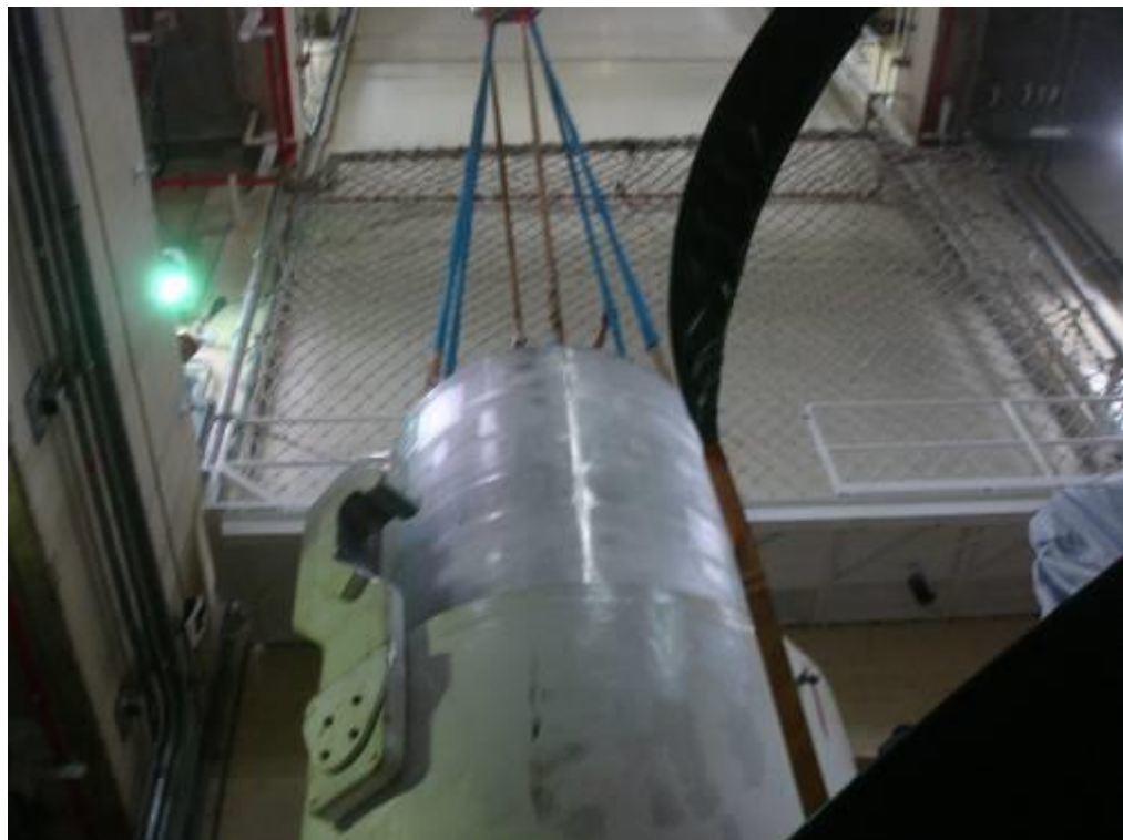
圖 3.2.14 密封鋼筒與傳送護箱結合
