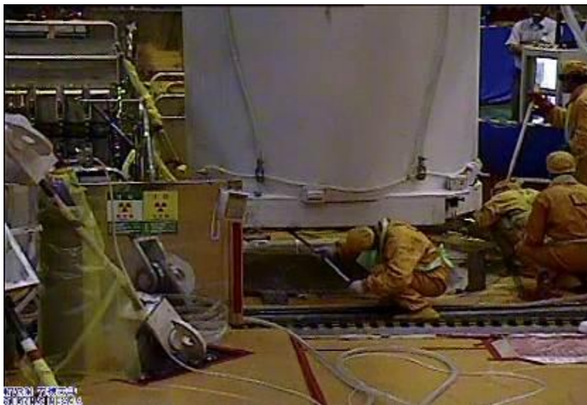
圖 3.3.18 傳送護箱底部擦拭除污
