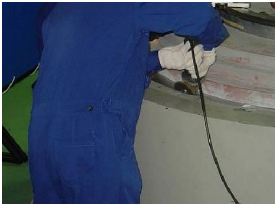
圖 3.1.8 結構上蓋銲道整修
