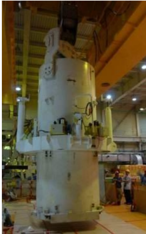
圖 3.2.27 傳送護箱加掛二樓防震裝置運往天井
