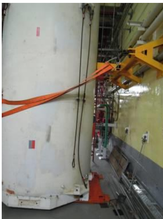
圖 3.2.6 準備將 TFR 固定於牆邊固定架
