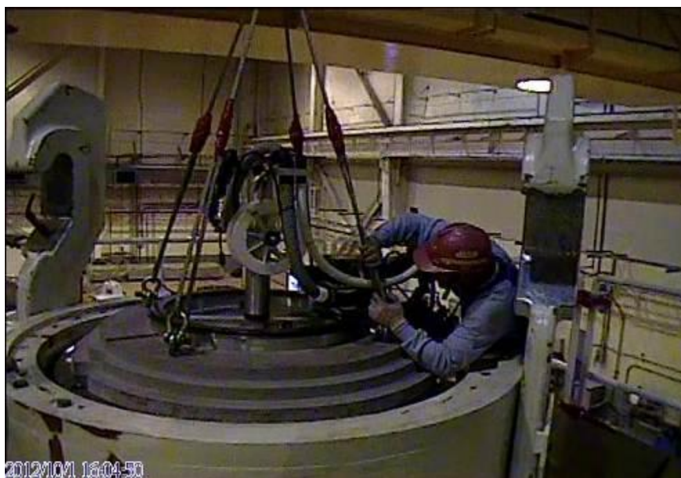
圖 3.2.22 結構上蓋安裝自動銲接機
