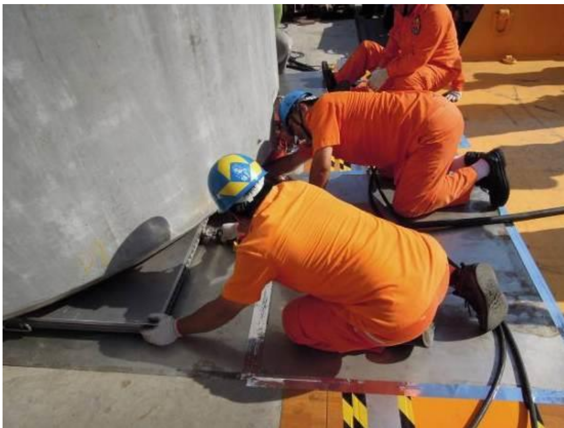
圖 3.2.23 VCC 底部安置懸浮氣墊組
