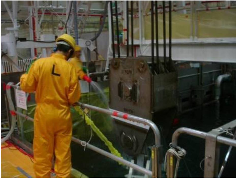
圖 3.3.6 出水時以除礦水沖洗吊軌、鉤頭及纜索並進行輻射劑量監測
