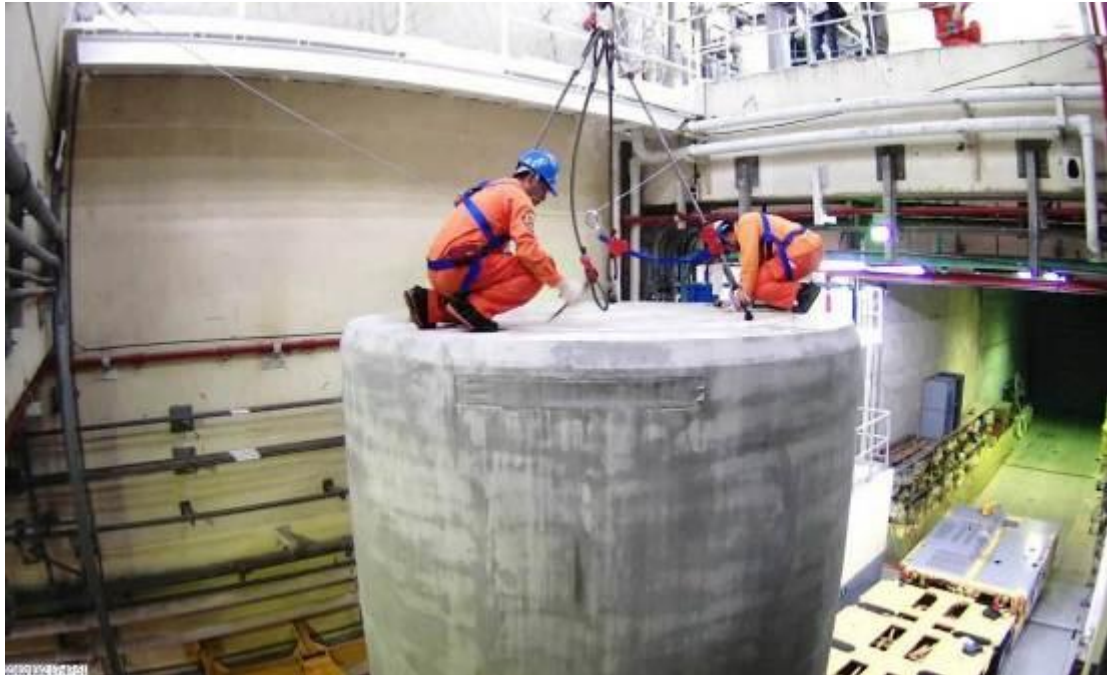
圖 3.2.35 安裝 VCC 頂蓋
