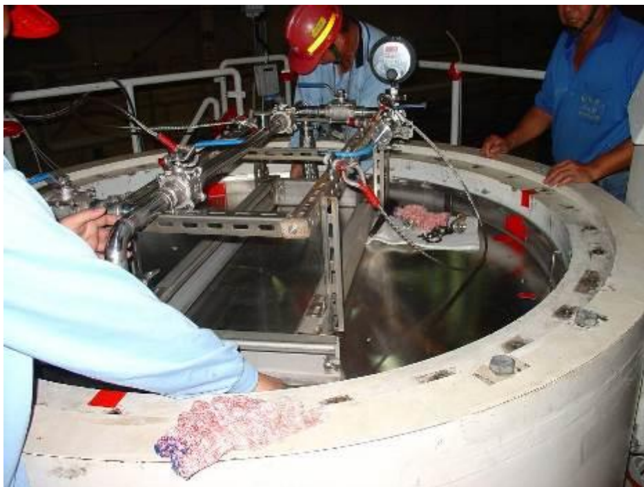
圖 3.2.19 安裝真空乾燥系統儀表架
