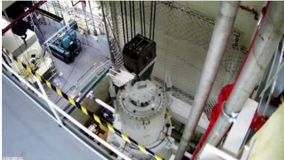
圖 3.2.31 以可遙控脫鉤吊具將 TSC 放入 VCC 內
