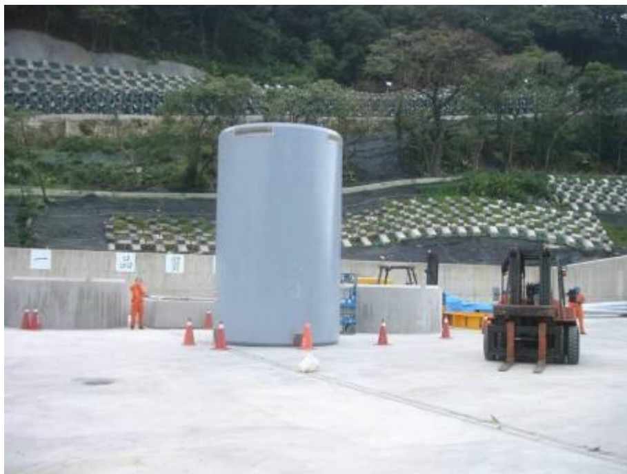
圖 3.2.64 混凝土護箱貯放於指定位置
