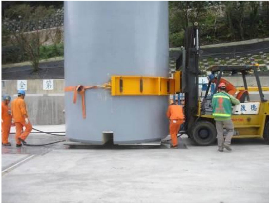
圖 3.2.63 利用氣墊將混凝土護箱運抵貯存場指定位置
