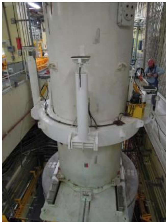
圖 3.2.44 以吊軛將傳送護箱吊置於 VCC 上
