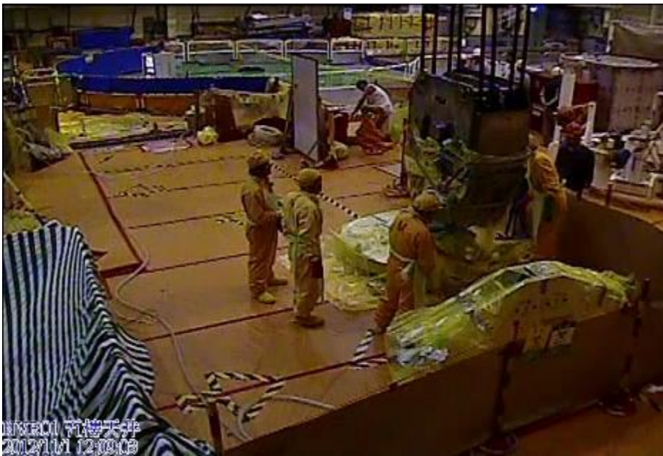
圖 3.3.7 出水後的吊軌與吊勾套袋後收存
