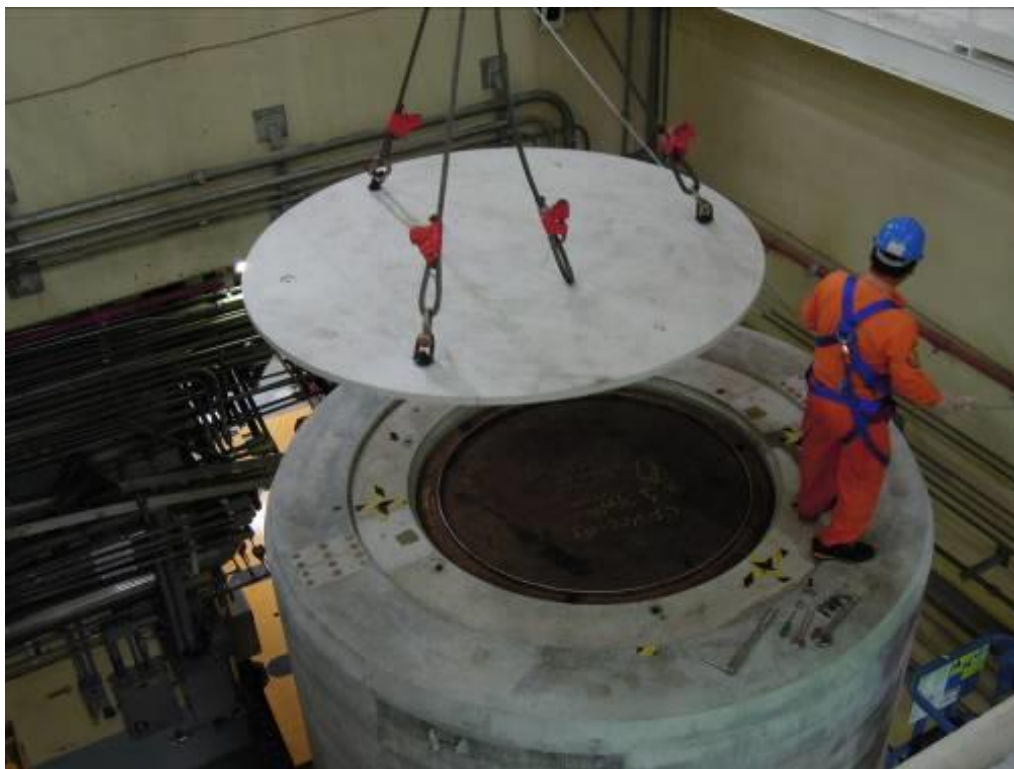
圖 3.2.40 將 VCC 之頂蓋吊離
