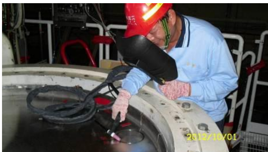
圖 3.2.20 模擬排水排氣孔口蓋銲接作業
