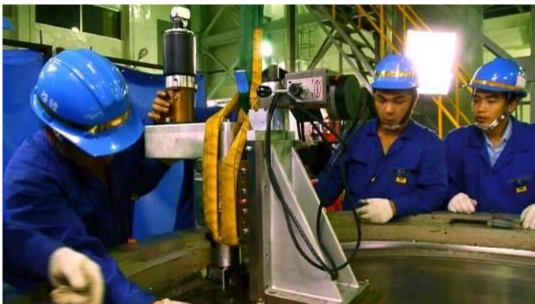
圖 3.1.17 安裝封口蓋鉸道切削設備
