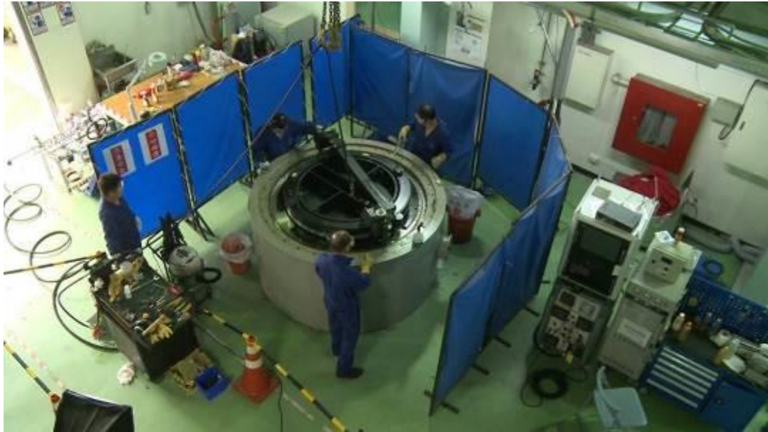
圖 3.1.15 結構上蓋銲道切割
