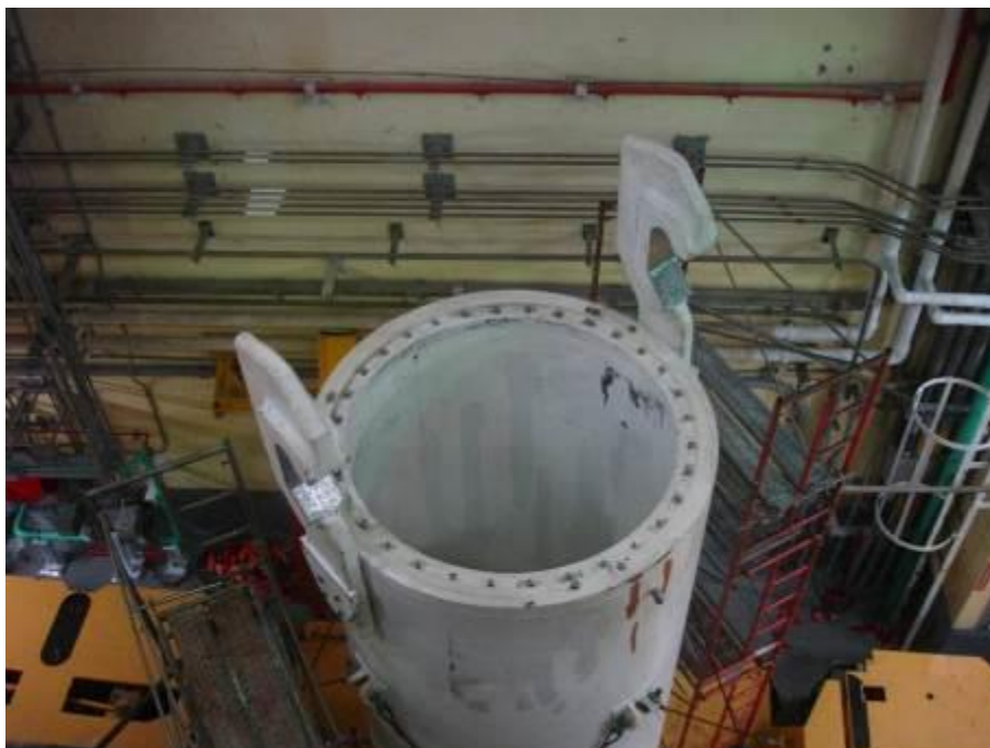
圖 3.2.5 J 型鉤安裝完成護箱頂部狀況
