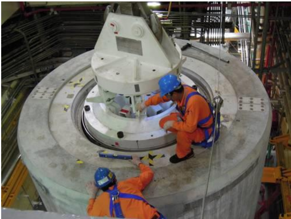
圖 3.2.42 安裝可遙控脫鉤吊具之吊環於鋼筒上
