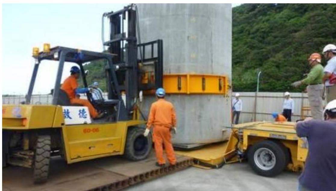
圖 3.2.24 VCC 移至多軸油壓板車上
