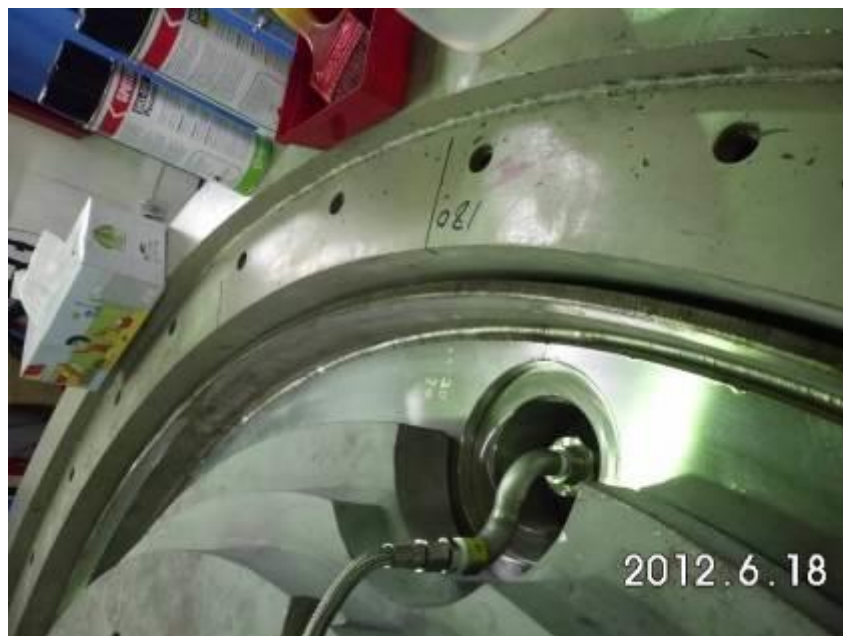
圖 3.1.5 氫氣偵檢與氫氣沖流系統於排水孔側管路特寫
