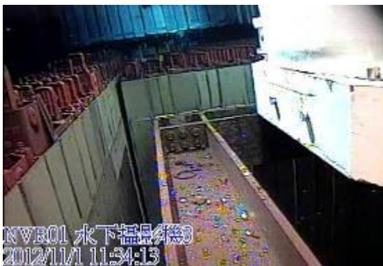
圖 3.3.4 傳送護箱底部通過裝載區框架
