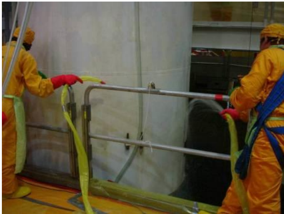
圖 3.3.2 下水時傳送護箱表面持續淋濕
