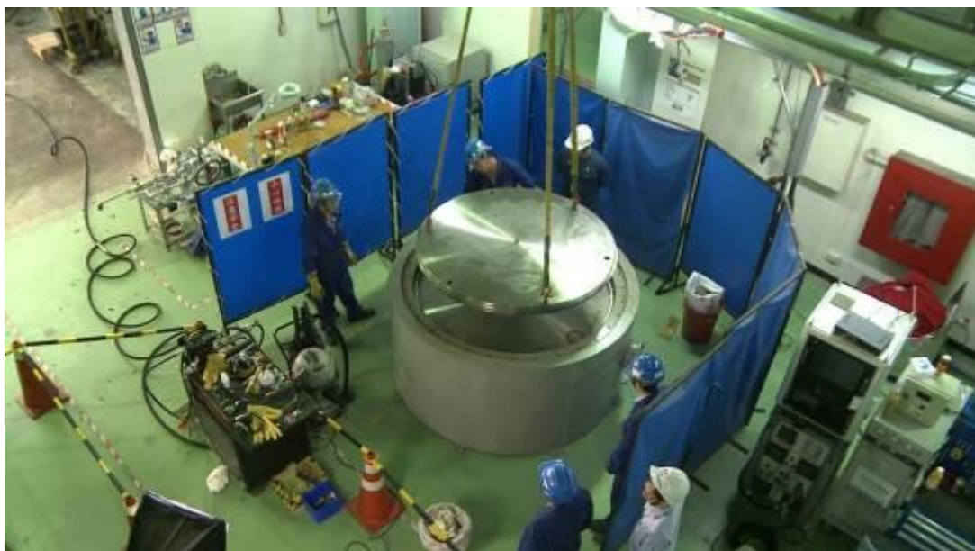
圖 3.1.16 結構上蓋成功吊離
