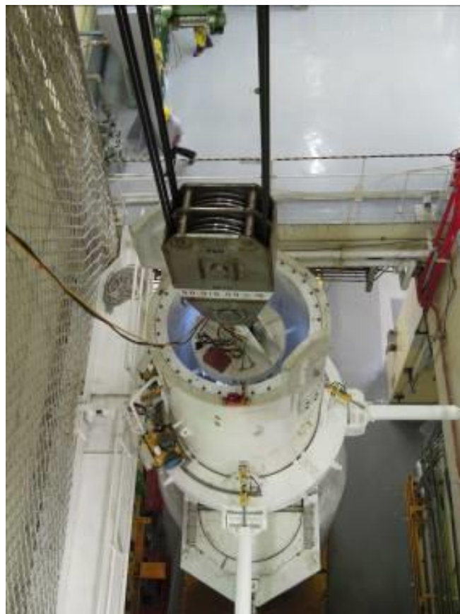
圖 3.2.46 可遙控脫鈎密封鋼筒吊具穿越傳送護箱內部
