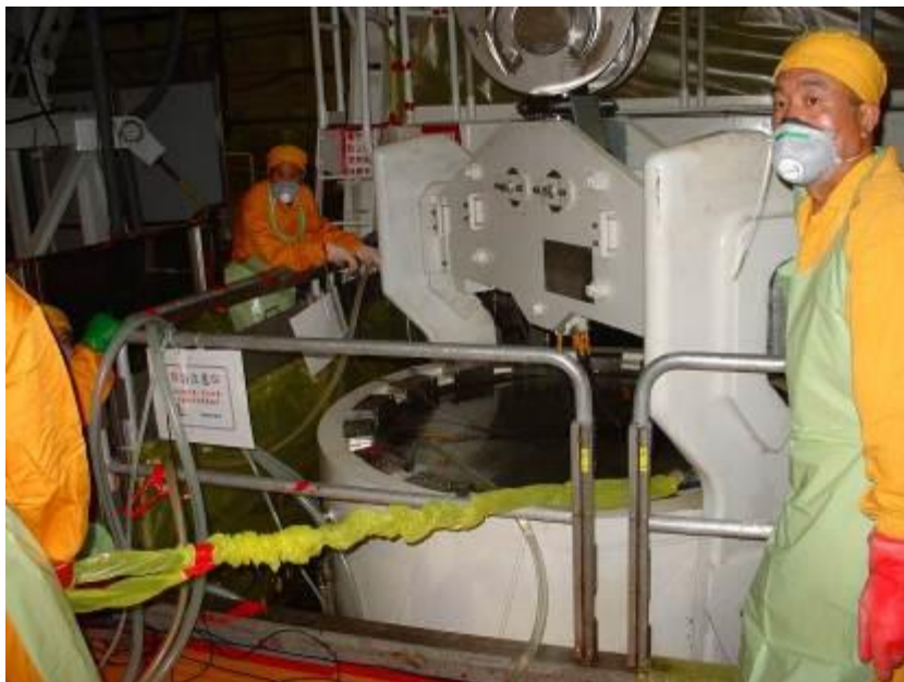
圖 3.3.16 排水 260 公升同時間測輻射劑量
