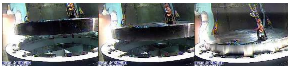
圖 3.3.11 水下安裝屏蔽上蓋之連續鏡頭
