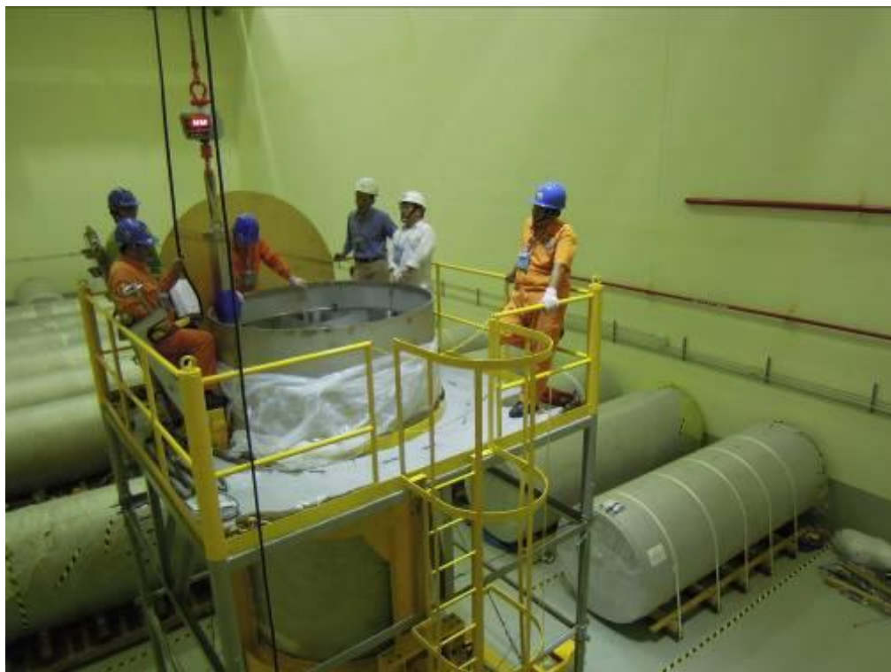
圖 3.2.11 TSC 燃料方管阻力測試(2)
