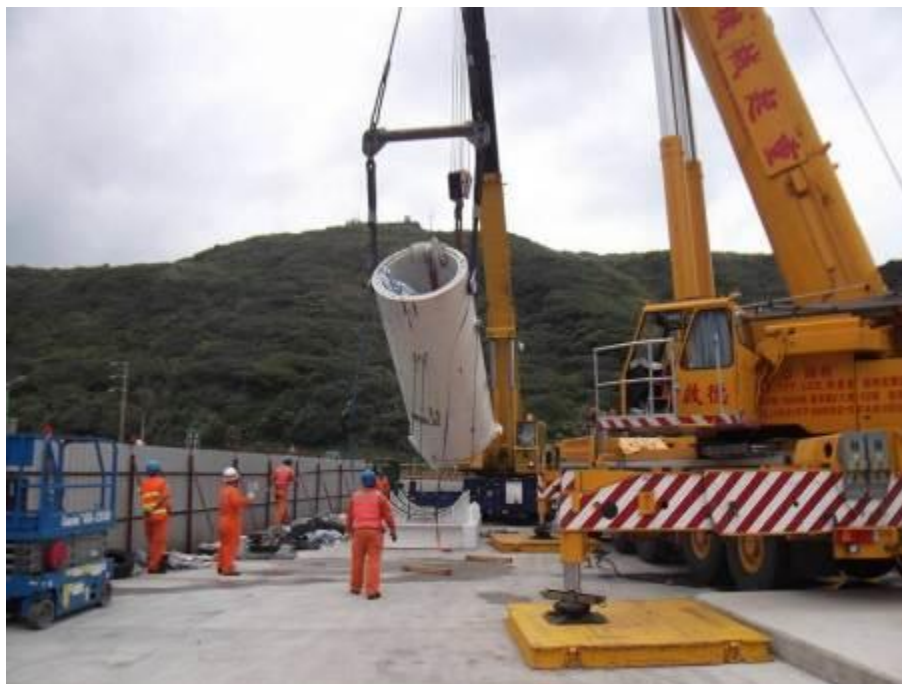
圖 3.2.1 傳送護箱翻轉成水平狀態
