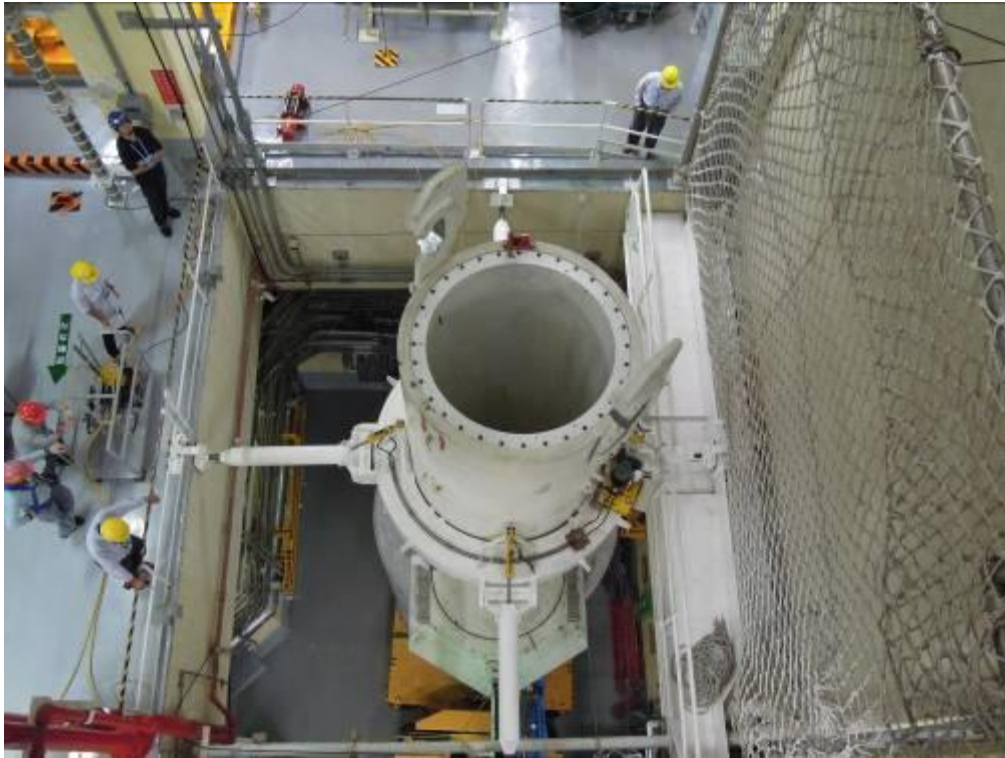
圖 3.2.45 傳送護箱座妥後放下 2F 防震裝置
