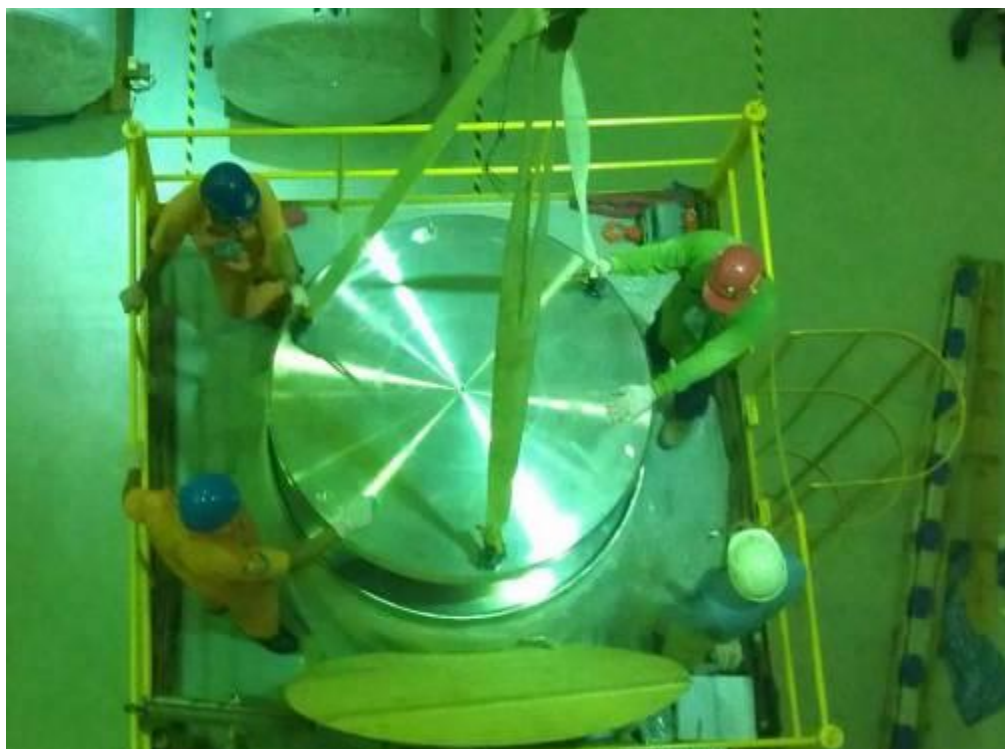
圖 3.2.8 密封鋼筒與結構上蓋組合測試
