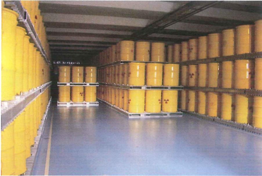
圖一、核能電廠現代化低放射性廢棄物貯存庫
