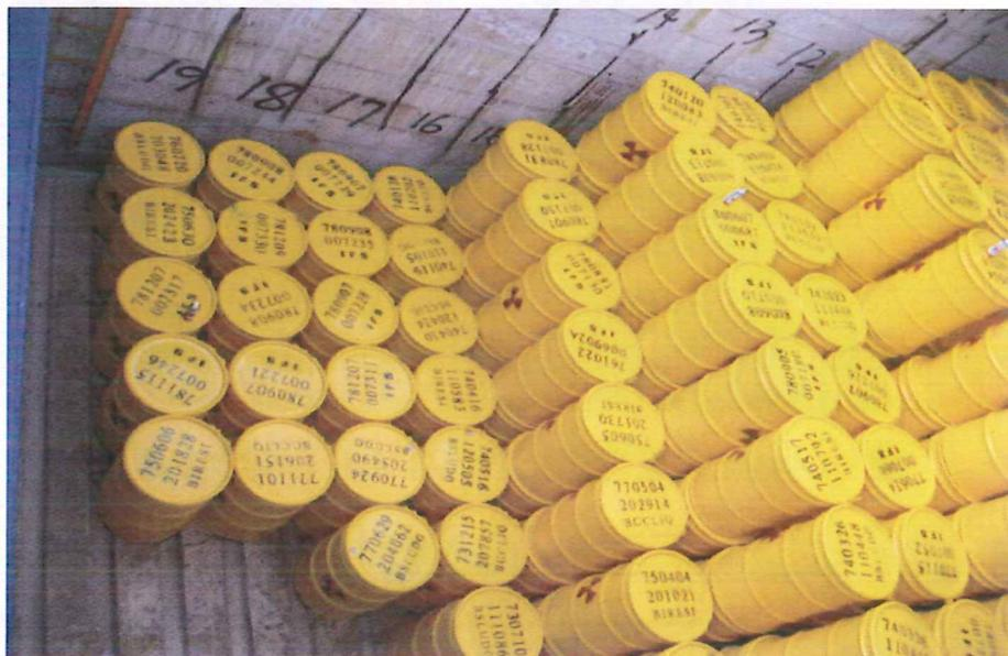
圖三、完成檢整作業後蘭嶼貯存場貯存壕溝內觀
