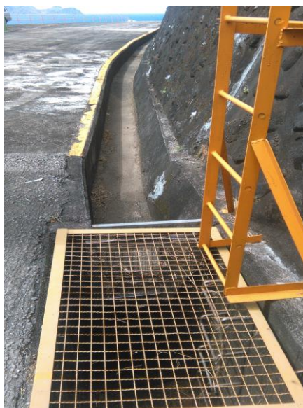
圖一 壕溝區內排水溝疏濬
