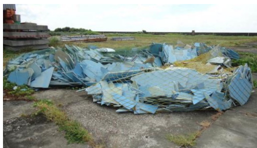
圖九 鋼構廠房屋頂隔熱板碎片未拉安全管制繩
