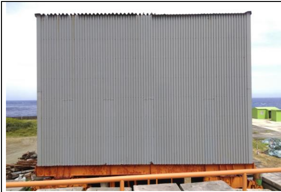
圖六 取出單元外圍鋼板接縫處銹蝕處已完成改善
