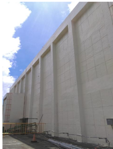
圖五 處理中心外牆垂掛之纜 線已完成改善
