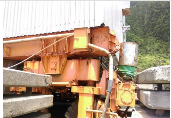
圖七 取出單元下方角突出的鋼條銹蝕已完成改善
