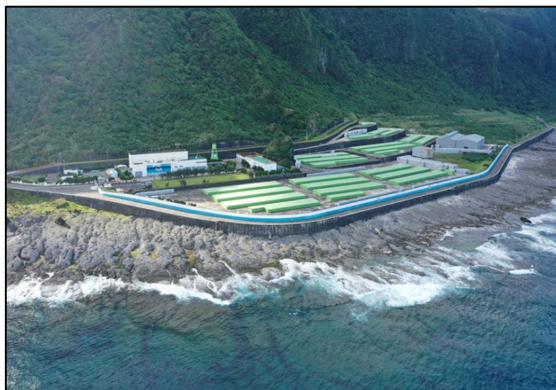
圖 4-2：低放貯存場全景
