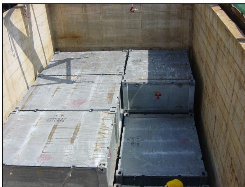
圖 4-3：低放貯存場廢棄物重裝作業
