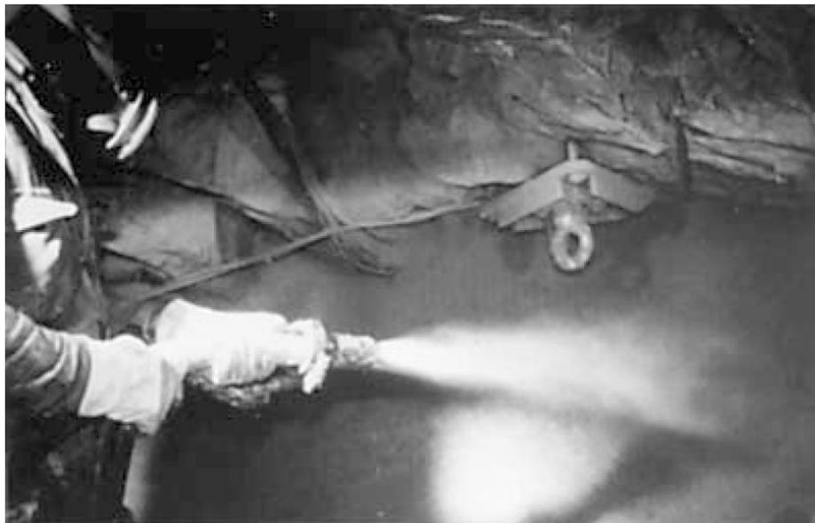
圖 2.1.1-3 噴注(shotcreting)方式施工(SK B TR-02-12)
