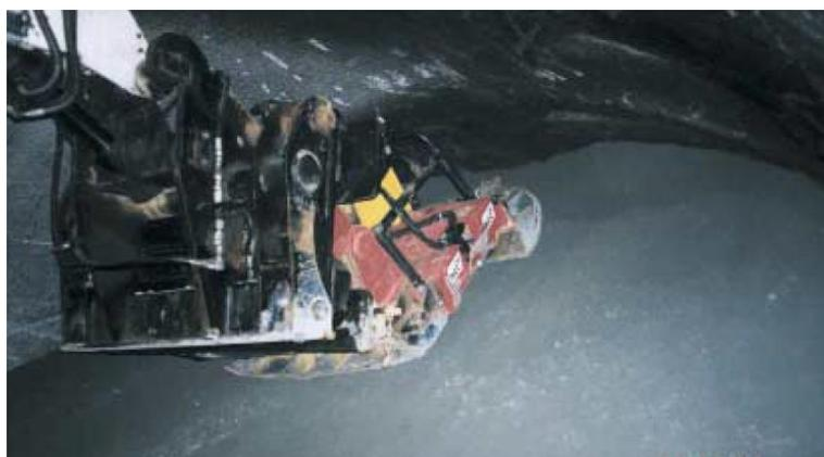
圖 2.1.1-2 旁道工法(sideways)壓實坑道頂部示意及壓實機具(SKB TR-02-12)
