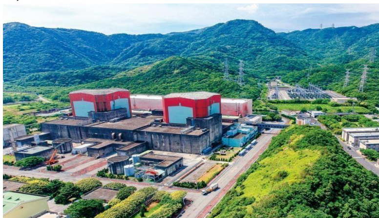
圖 2.1.1-1 核二廠一、二號機設施
