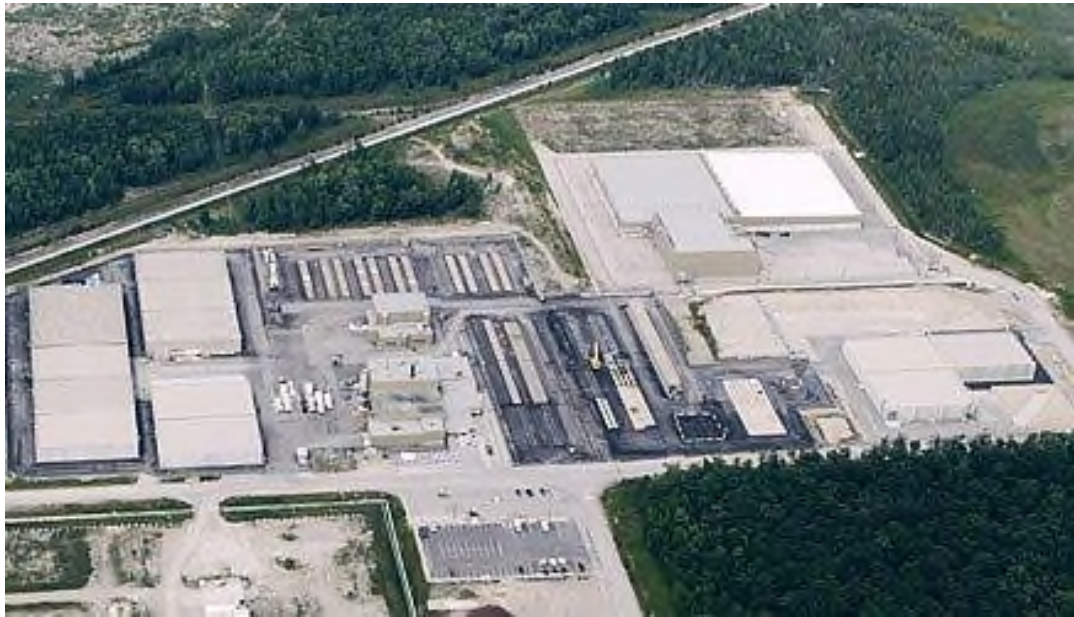
圖 4 WWMF 設施照片
