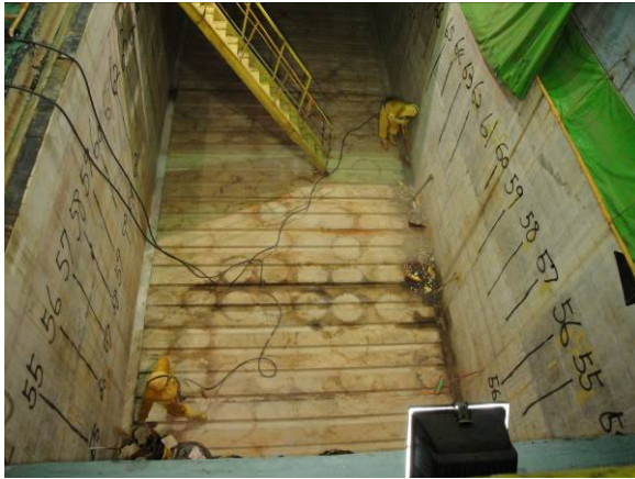
檢查壕溝清理情形
