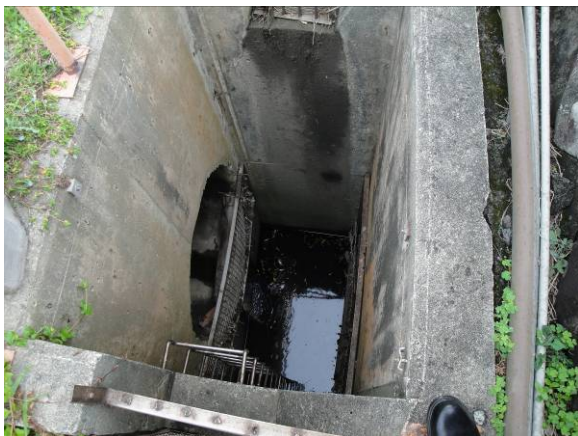
檢查排水渠道
