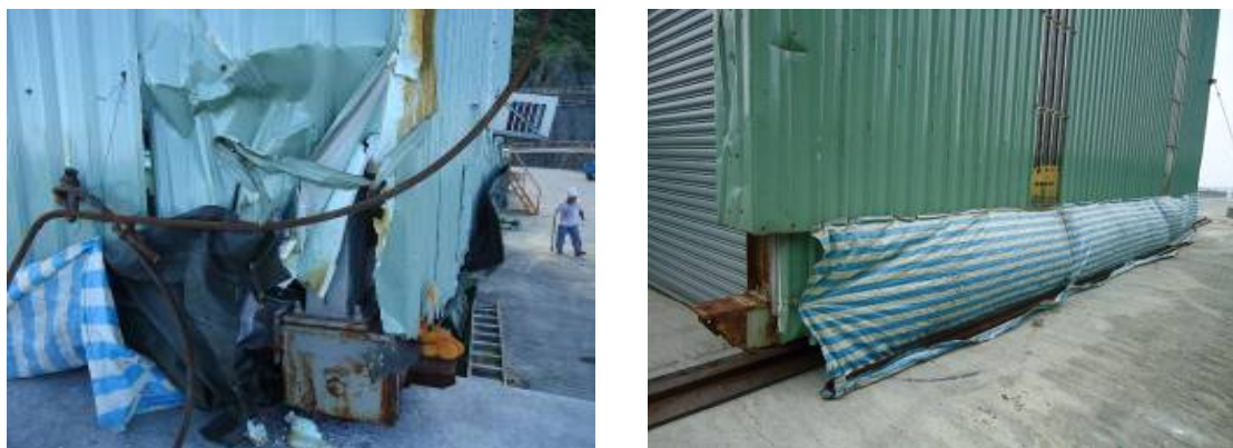
圖五 小型遮蔽物件一角損壞及帆布鼓起
