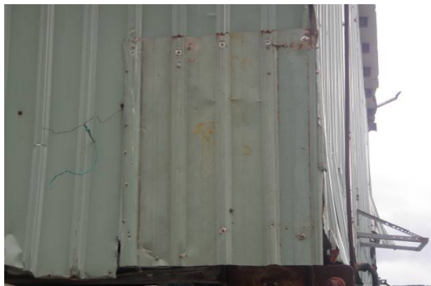
圖七 小型遮蔽物件廠房角落損壞已經完成修復
