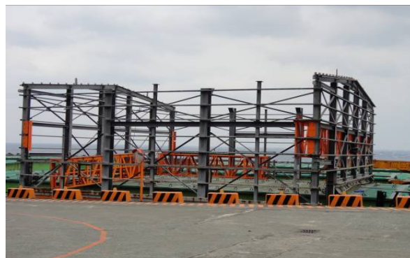
圖八 大型遮蔽物件目前正進行拆除作業中
