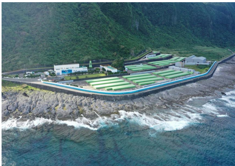
圖 4-2：低放貯存場全景
