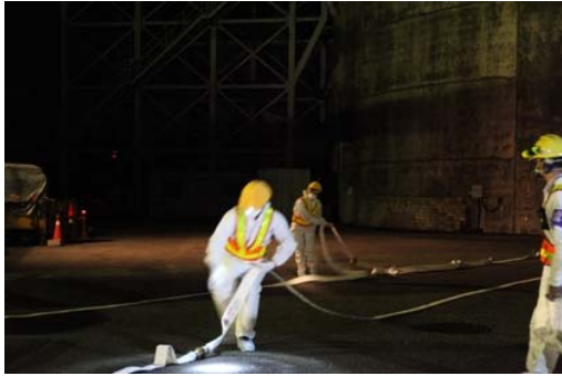
進水口碼頭抽取海水補至用過燃料池作業
