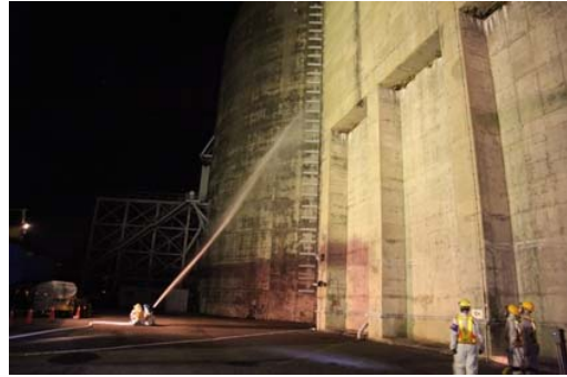
進水口碼頭抽取海水補至用過燃料池作業
